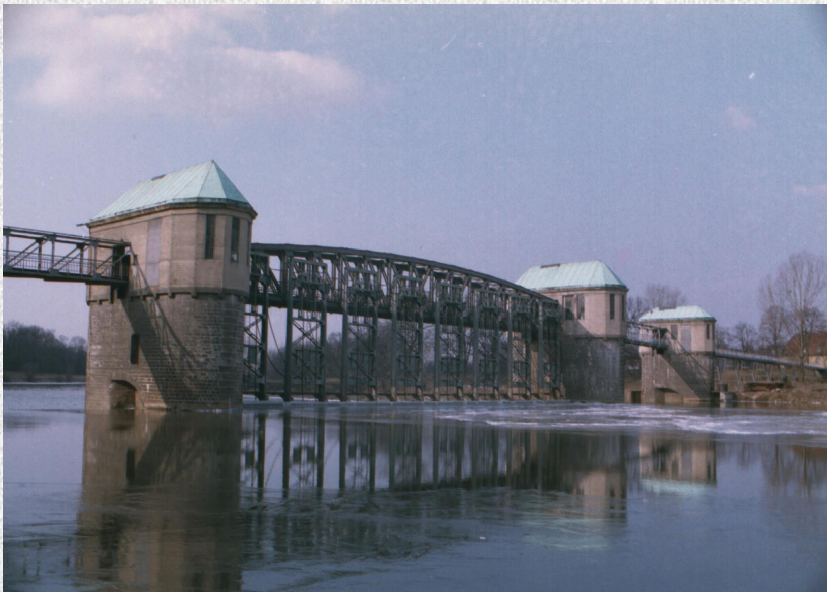
Jaz piętrzący na stopniu wodnym „Rędzin” we Wrocławiu, 1913-1917
