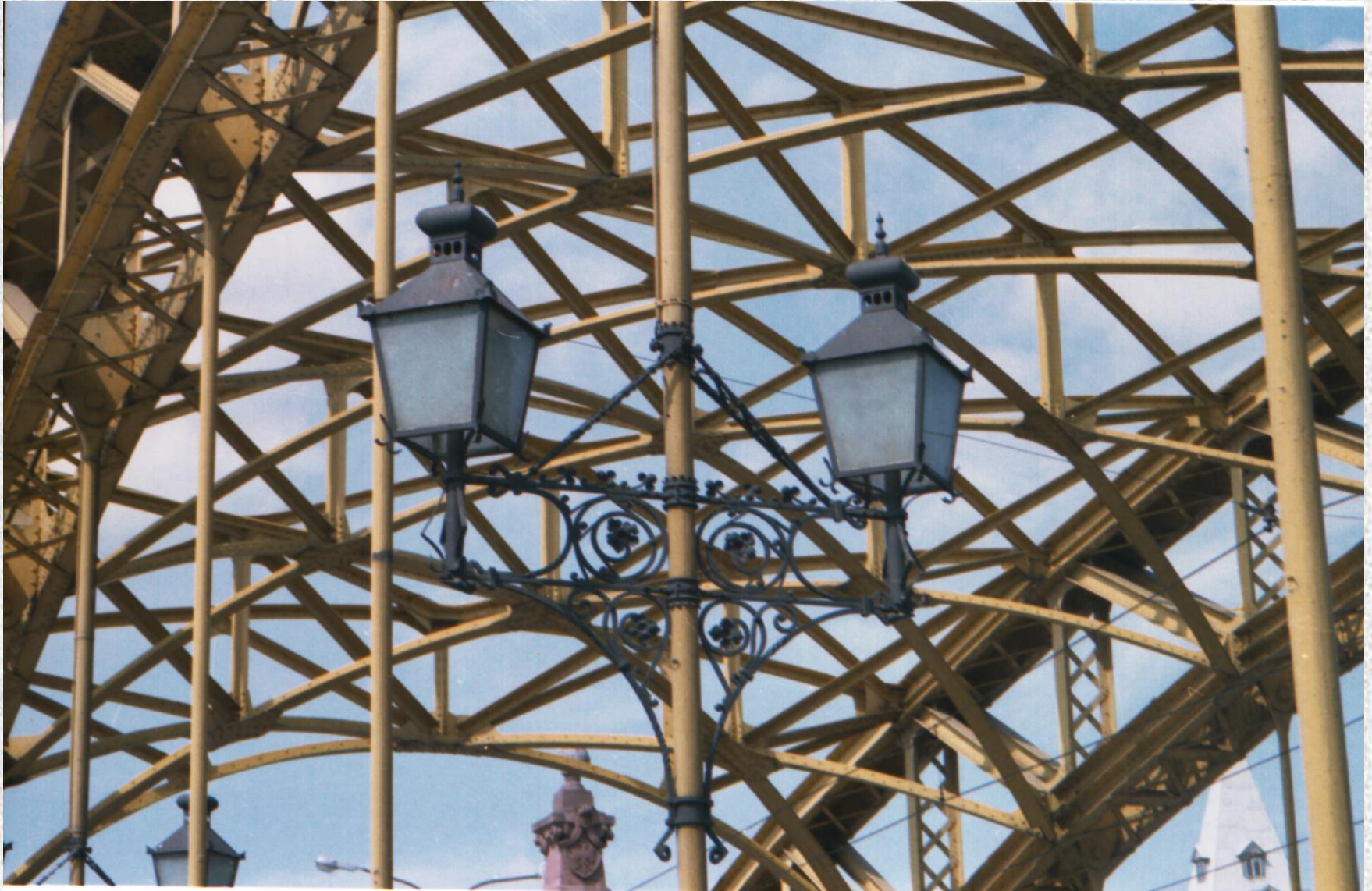
Most Zwiryniecki we Wrocławiu – konstrukcja stężeń wiatrowych
