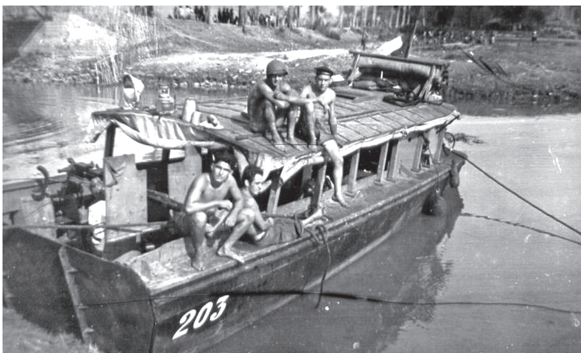
Kuter desantowy typu LCVP zmodyfikowany poprzez zamontowanie opancerzenia burtowego i lekko opancerzonego dachu. Jednostki tego rodzaju uzbrajane były w karabiny maszynowe 7,5 i 7,7 mm oraz 12,7 mm, 20 mm armaty Oerlikon, a nawet granatniki Piat, źródło: Marine Nationale.
