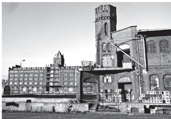
Architektura magazynów Portu Miejskiego na Kleczkowie, 1897-1901
