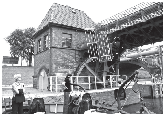
Śluza Różanka z zamknięciem głowy górnej podnoszonym segmentem, 1916
