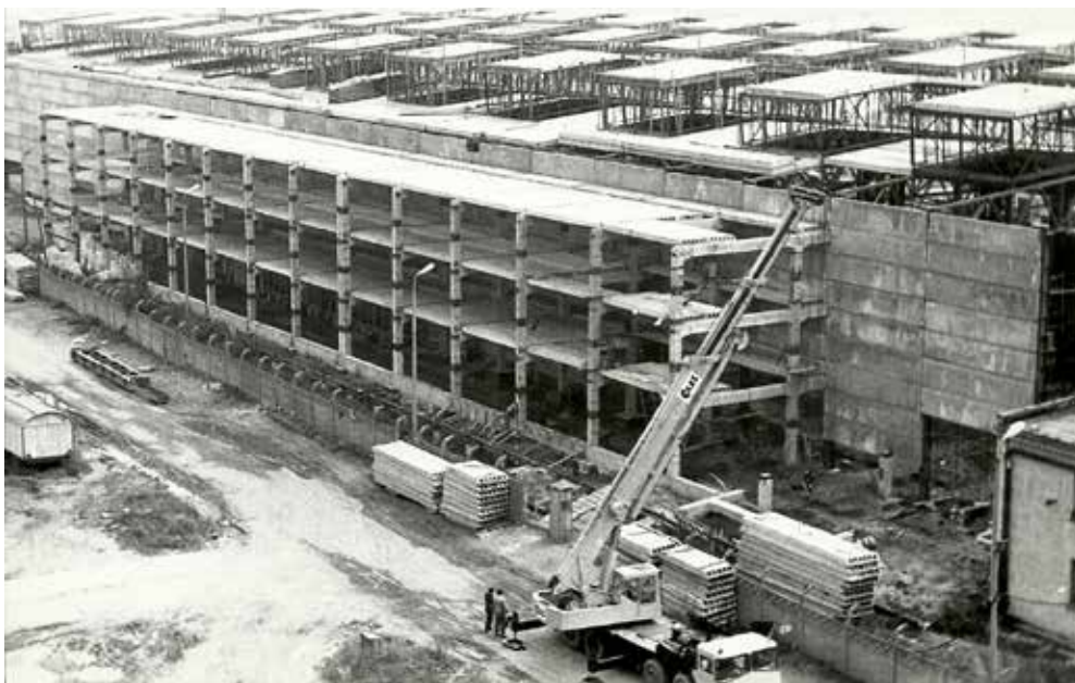
Rozbudowa ŚFUP. Hala aparatury w trakcie budowy, 1974 r.
