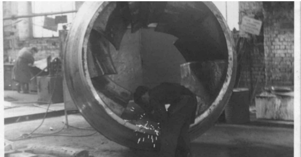
Pompa akumulacyjna 2NA-27, wirnik o średnicy 2200mm w trakcie spawania
