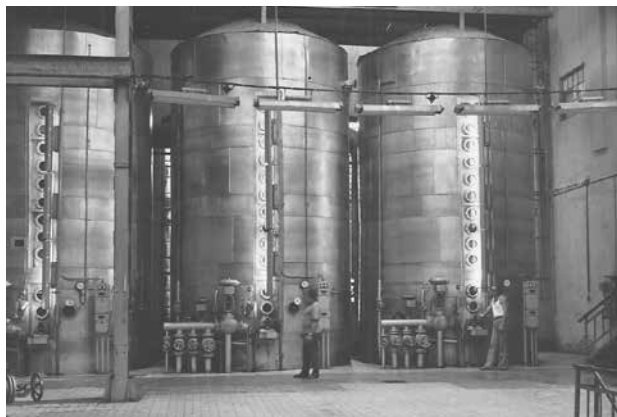
Cukrownia MOGAN VALEY Iran, rok 1981. Po lewej stronie widoczny piec wapienny prod. ŚFUP. (charakterystyczny obiekt w każdej cukrowni)
