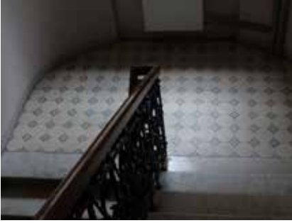
Posadzka w kamienicy przy ul. Mokotowskiej 7 w Warszawie. Fot. Z. Michalczyk, 2014
