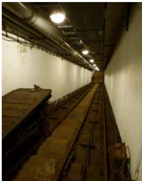
Rampa komunikująca bunkier wejściowy z podziemnym systemem korytarzy i hal, foto S. Januszewski
