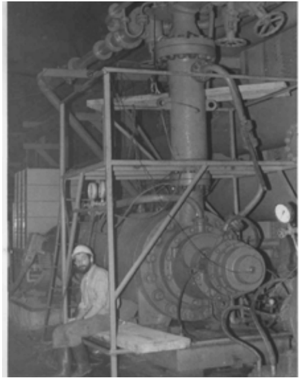
KGHM ZG Rudna – komora głównego odwadniania, agregat pompowy 200YSC, 1978 r.
