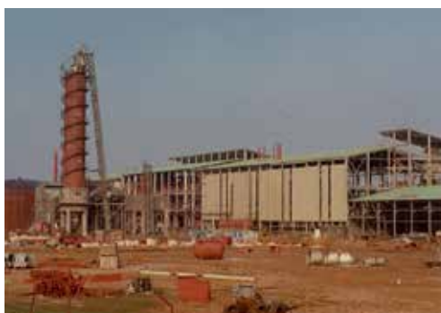
Cukrownia MOGAN VALEY Iran, rok 1981. Po lewej stronie widoczny piec wapienny prod. ŚFUP. (charakterystyczny obiekt w każdej cukrowni)
