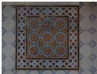
Posadzka w kamienicy przy ul. Mokotowskiej 5 w Warszawie. Fot. Z. Michalczyk, 2014
