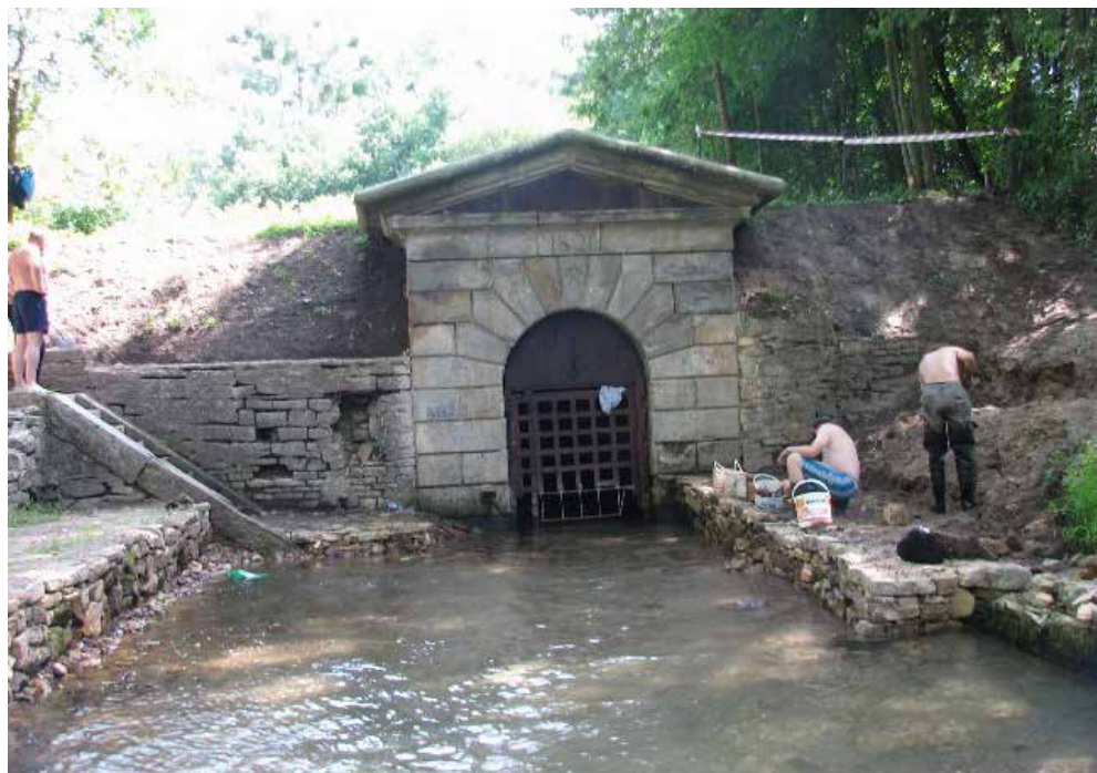
Prace remontowe przy Bramie Gwarków w Ptakowicach.
