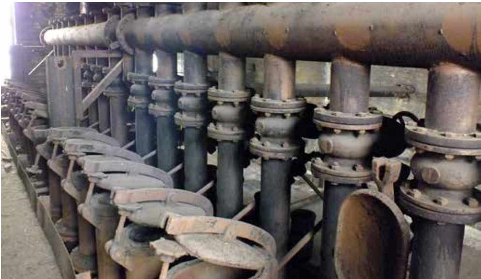
Międzyzlesie, Teleskopowy zbiornik gazu typu mokrego, foto S. Januszewski, 2013
