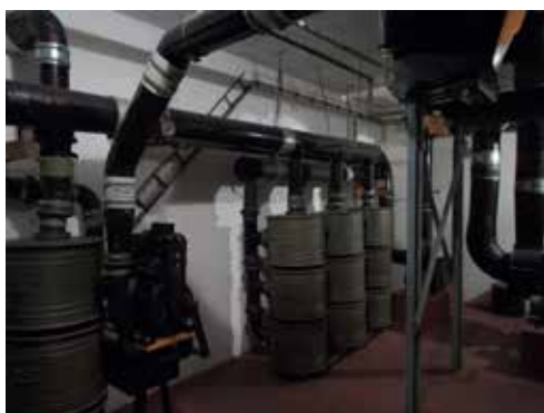
Hala filtrów powietrza, foto Tomasz Dąbrowski z Větrkovic u Příbrna, foto S. Januszewski
