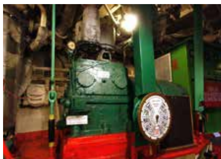
Maszynownia s/s SOŁDEK, maszyna parowa K5 do napędu agregatów prądotwórczych
