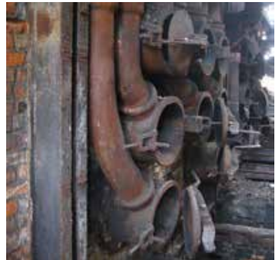
Międzylesie - Piecownia, Piece retortowe do odgazowywania węgla, foto S. Januszewski, 2013 Najświętszego Zbawiciela, Warszawa.
