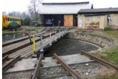
Parowozownia wachlarzowa, 4-stanowiskowa z obrotnicą, foto S. Januszewski
