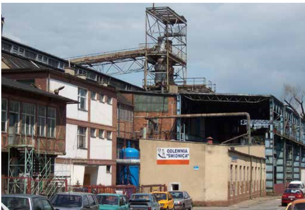
Odlewnia Świdnica, spadkobierca tradycji odlewniczych firmy Främb & Freudenberg. Po lewej stronie widoczny fragment ściany, o konstrukcji szkieletowej, budynku biurowego z XIX w. Stan obecny
