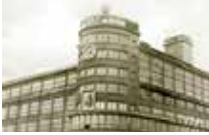
Budynek, w którym mieściło się Centralne Biuro Konstruktorskie CKB-29 w Moskwie (tupolewska szaraszka-
