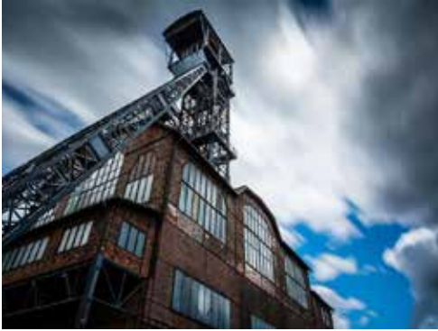
Nadszuby i wieża nadszubyowa szybu F Hlubina, foto internet
