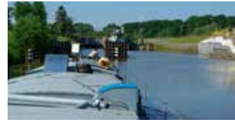
Wejście do komory śluzy Rogowo
