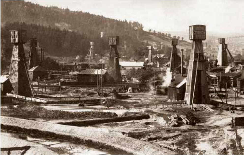
Szyby głębinowe dobywające olej skalny
