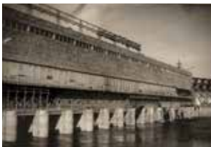
Здание станции. Вид со стороны нижнего бьефа, Октябрь 1932 года
