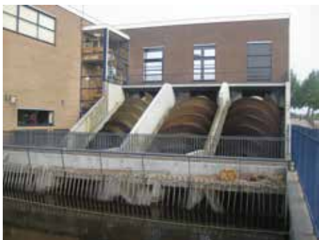
Stacja pomp Van Haften, 1927
