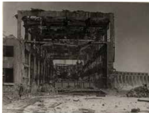
Днепрогэс в марте 1944 года. Разрушенное здание ГЭС
