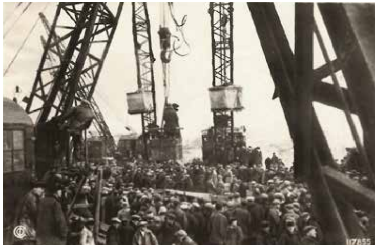
Последняя бадьа бетона, 1932 год
