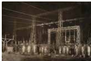
Открытое распределительное устройство 161 кВт, Ноябрь 1933 года
