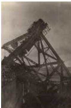
Днепрогэс в марте 1944 года. Разрушен кран щитовой стенки
