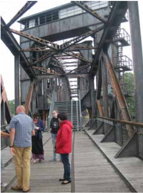
Most kolejowy z przeszłem podnoszonym
