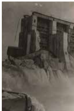
Днепрогэс в марте 1944 года. Разрушен сопрягающий устой
