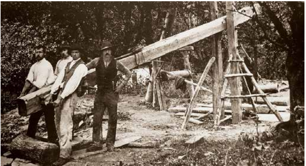
Robotnicy przy ręcznym, drewnianym krowie nad studnią – kopanką
