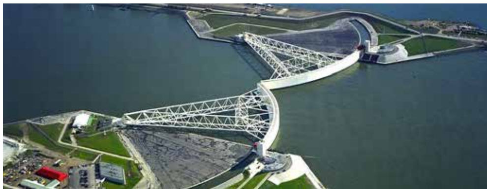
Maeslantkering - obrotowa zapora wodna
