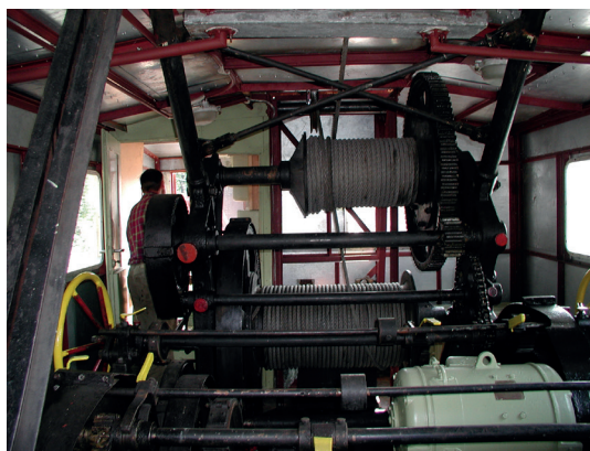
Kołowroty w maszynowni dźwigu
