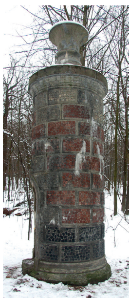
Wieżyczka wentylacyjna kolektora głównego w Lasku Bielańskim (zdj. autora)
