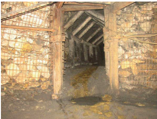
Rys. 7. Współczesna, stalowa, obudowa skrzyżowania dwóch chodników pochodzących z początków XIX wieku
