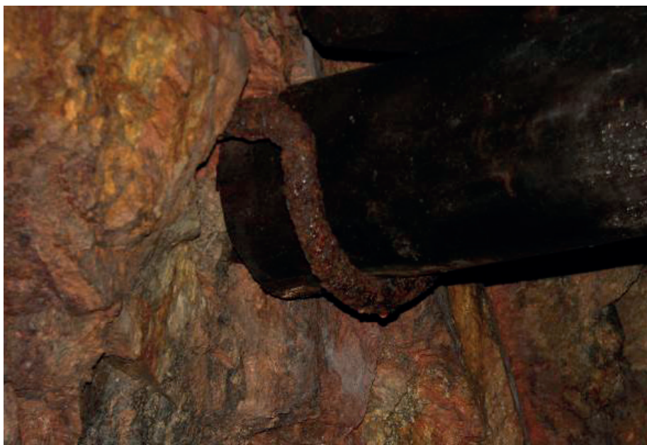
Rys. 19. Stropnica drewniana zabudowana na wieszaku stalowym zakotwionym w ociosach, wyrobisko z końca XVII wieku
