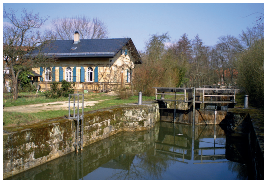
Budynek mieszkalny obsługi śluz nr 100 w Bambergu, foto Andre Kraut
