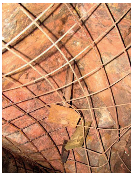
Rys. 3 Kotew stalowa cierna zabudowana w stropie wyrobiska
