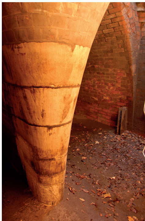
Ciosy kamienne na zakończeniu ściany wewnętrznej zbiornika (zdj. autora)
