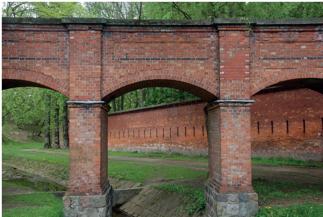
Akwedukt kanalizacyjny w zachodniej części Cytadeli Warszawskiej, widoczna rzeźba terenu – kilkunastometrowy spadek Skarpy Warszawskiej (zdj. autora)
