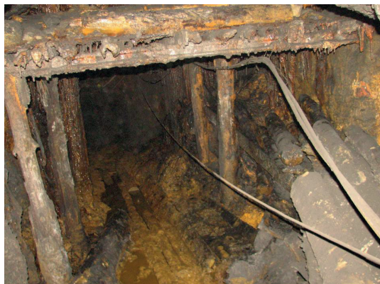
Rys. 1 Zniszczona obudowa chodnika wymagająca pilnej renowacji
