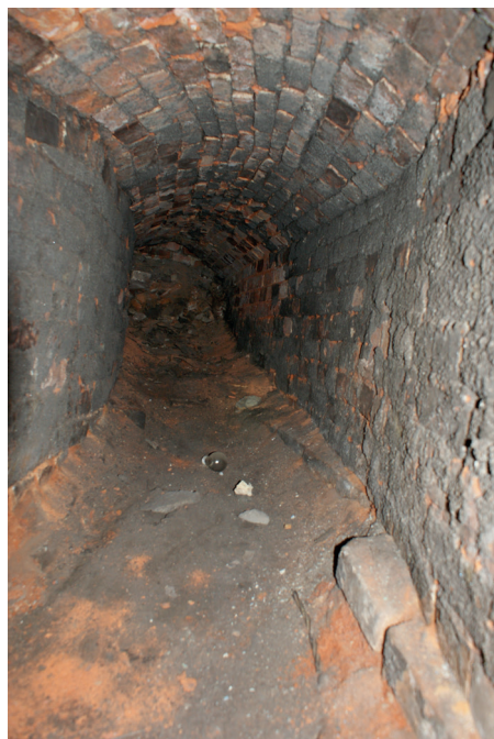
Fragment zaślepiętego murem kanału spalin grzewczych po byłym piecu wentylacyjnym, widoczne osmolone cegły.
