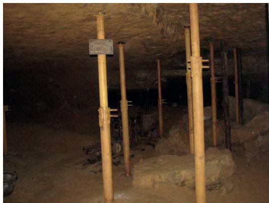
Rys. 11. Zabezpieczenie stropu przy pomocy metalowej obudowy podporowej stojakami SN 400
