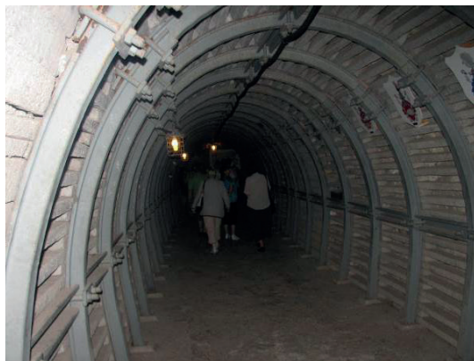
Rys. 12. Stalowa obudowa chodnika typu LP w wyrobiskach z XVI wieku
