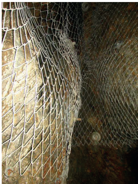
Rys. 13. Siatka ogrodzeniowa opinająca spękanie odciosy mocowana za pomocą kotwi wklejanych
