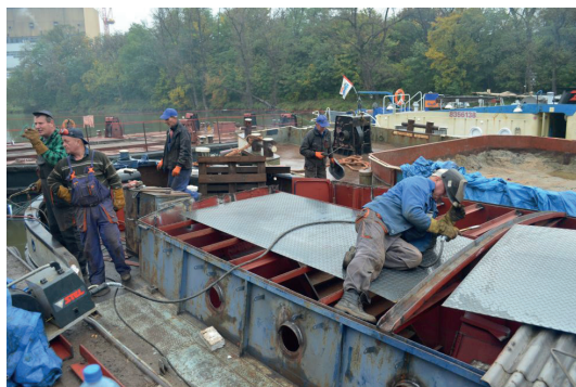
Odbudowa przekrycia ładowni
