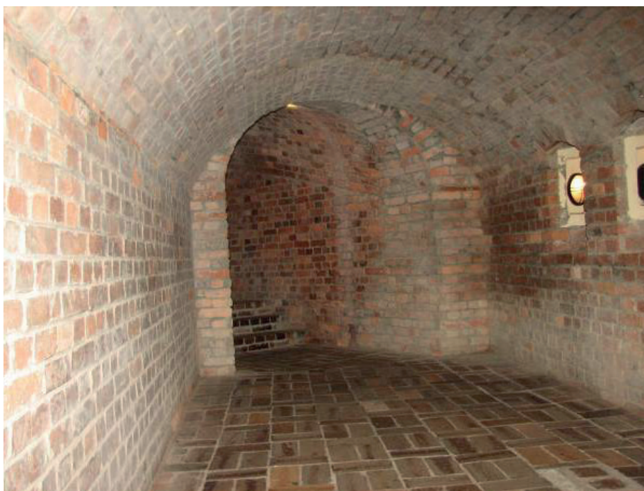
Rys. 18 Komora i wejścia do chodnika, wyrobiska z XVI wieku, obudowa wykonana współcześnie murowana z cegły na zaprawie cementowej
