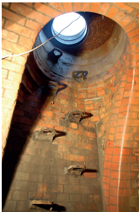
Detal styku obudowy włazu ze sklepieniem zbiornika przemylającego (zdj. autora)
