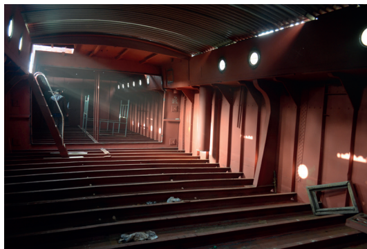
Zabezpieczenie antykorozyjne ładowni pod pokładem barki
