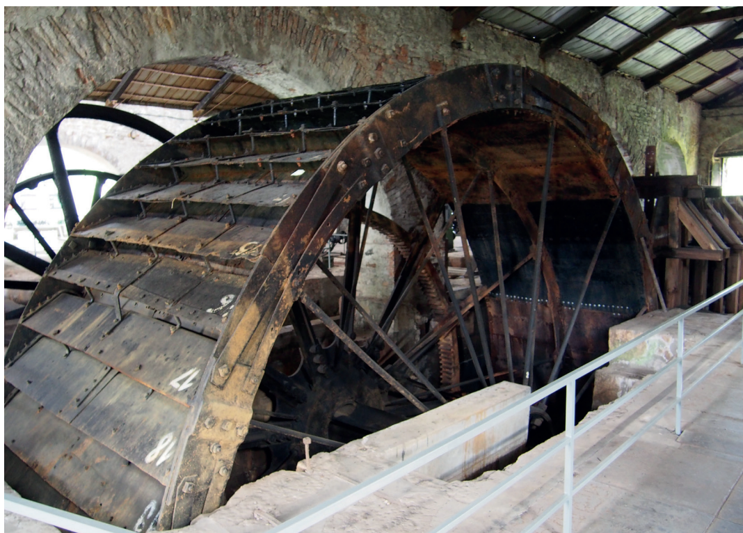
Koło wodne siłowni energetycznej
