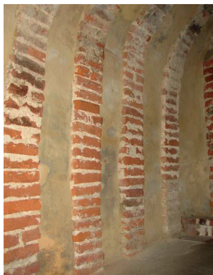
Rys. 16. Żebra murowane z cegły wzmocniające wyrobisko z XVI wieku
