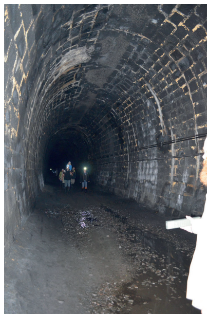
Sztolnia między równoległymi tunelami z 1879 i 1910-1912
