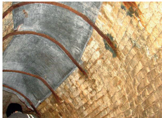
Rys. 8. Zabezpieczenie turystów przed wodą sącząca się ze stropu
