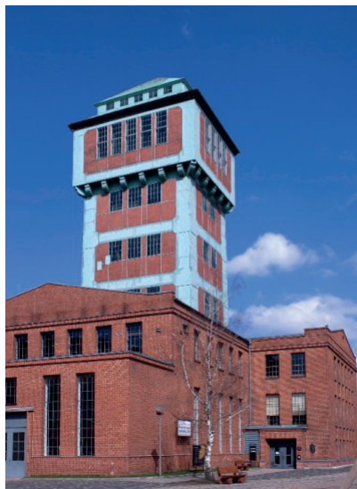
Wieża wyciągowa szybu kopalni „Karl Liebknecht” w Oelsnitz/Erzgeb, źródło: internet.
