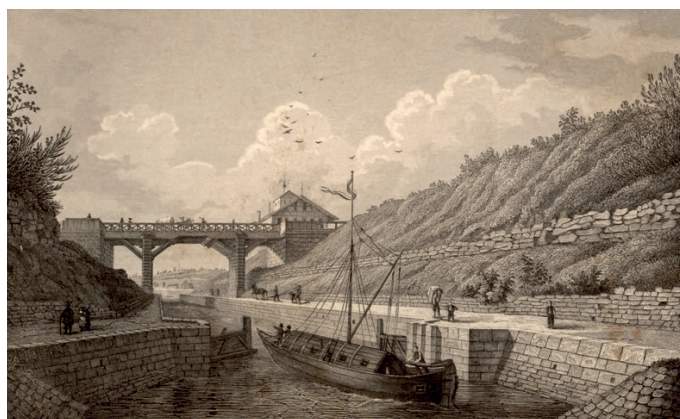
Koryto kanału prowadzone w wykopie pod Dörlbacher, w km 82,1 w 1845 r.
