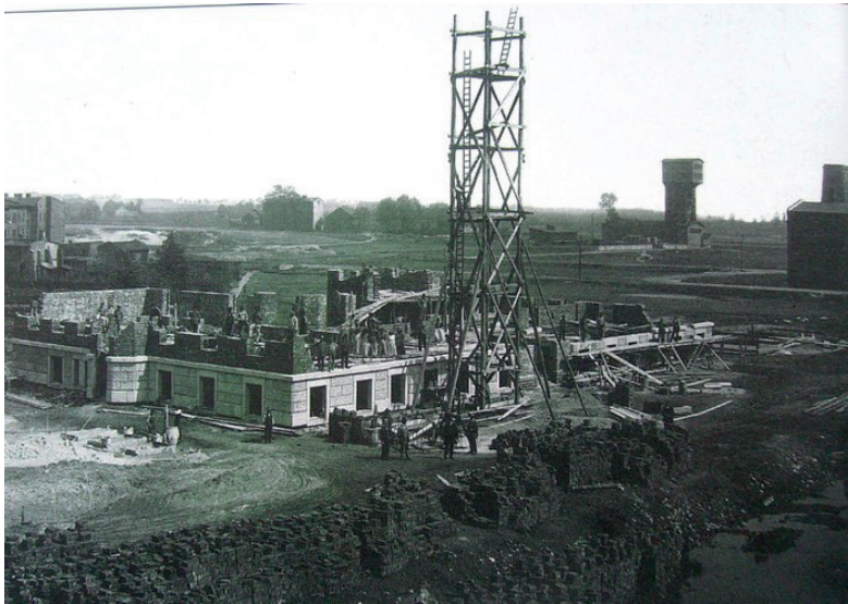
Budowa ratusza w Chorzele Batorym – w tle widoczna wieża Ulricha kopalni „Kleofas”, źródło: internet.
