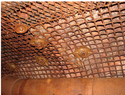
Rys. 2 Zabezpieczenie stropu wyrobiska za pomocą obudowy kotwowej
