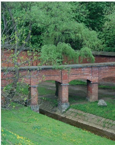
Detal akweduktu, w tle mur obwodowy Cytadeli (zdj. autora)
