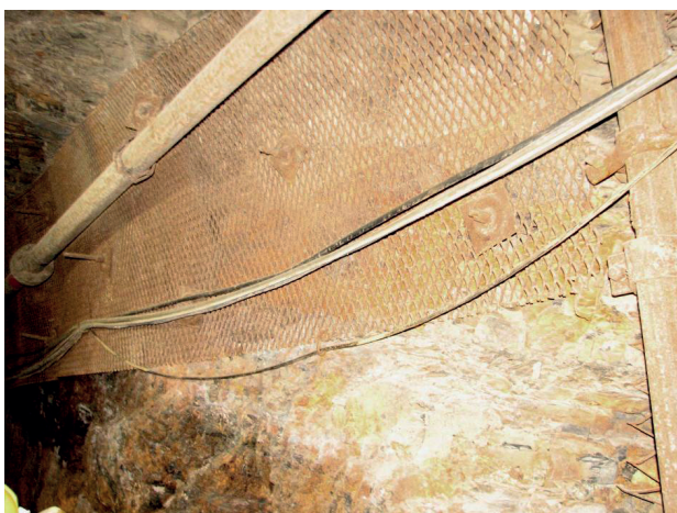
Rys. 4. Zabezpieczenie ociosów wyrobiska za pomocą obudowy z kotwi stalowych wklejanych i siatek stalowych
