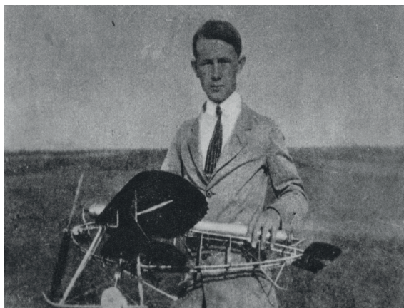
Ryszard Bartel z modelem samolotu o automatycznej równowadze poprzecznej napędzany silnikiem pneumatycznym; źródło: E. Banaszczyk, Pierwsze skrzydła, wyd. MON, Warszawa 1972.
