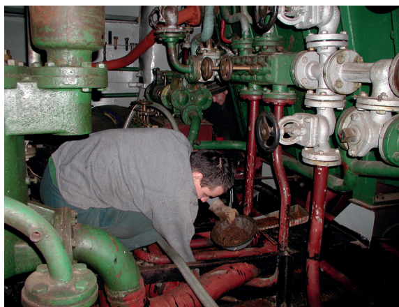
Czyszczenie żęzy w maszynowni HP Nadbor
