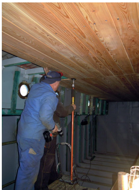
Wykonywanie instalacji elektrycznej ładowni
