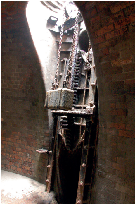
Zasuwa na zachodnim końcu zachodniego zbiornika przemywającego (zdj. autora)
