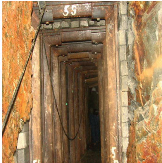
Rys. 14. Obudowa stalowa odrzwiowa wykonana z kształtownika V
