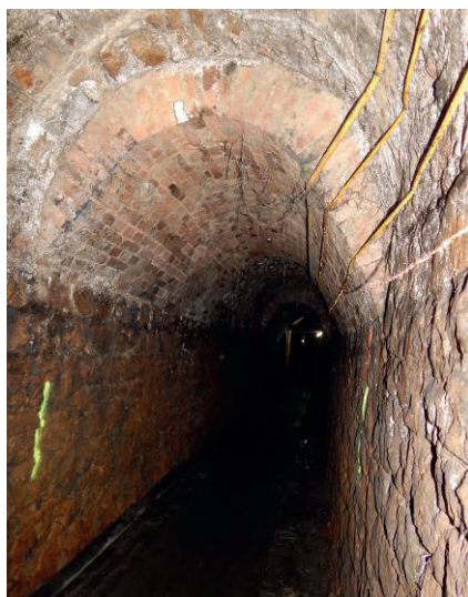
Rys. 15. XX wieczne wzmocnienie sklepienia za pomocą muru z cegły na zaprawie cementowej w wyrobisku z końca XVIII wieku
