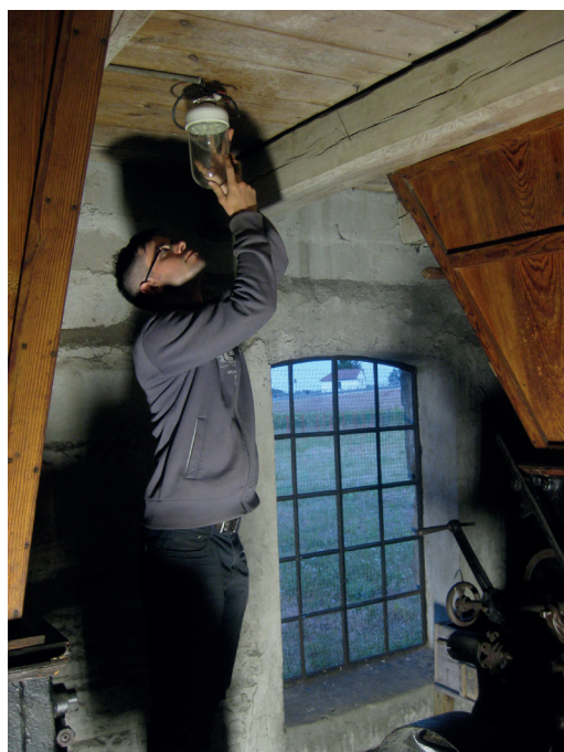
Montaż opraw świetlnych
