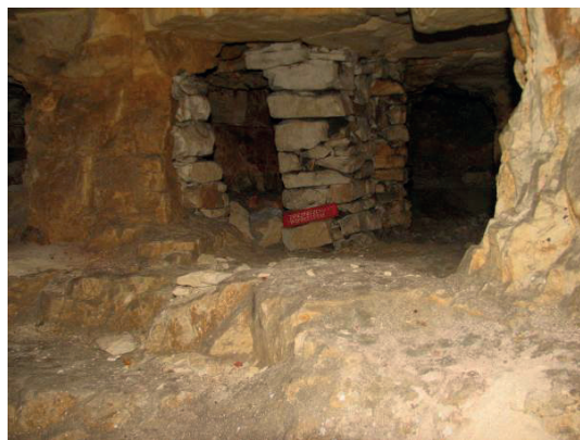
Rys. 9. Informacja o fakcie nieoryginalności zastosowanego sposobu podparcia stropu
