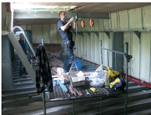
Montaż sufitów w ładowniach barki
