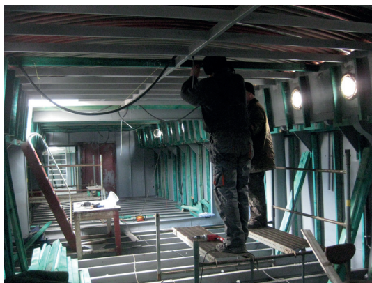
Zabudowa stelaży stalowo-drewnianych pod deskowanie sufitów i burt
