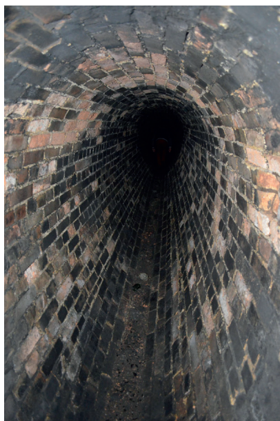
W tunelu kolejowym pod Małym Wołowcem
