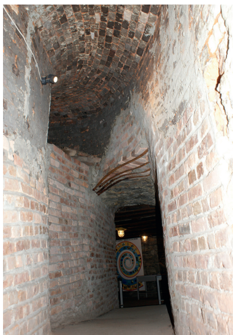
Kopalnia Guido na trasie turystycznej na poziomie 170 m widoczny przy szybie (pod stropem) fragment kanału dla spalin grzewczych po byłym piecu wentylacyjnym.
