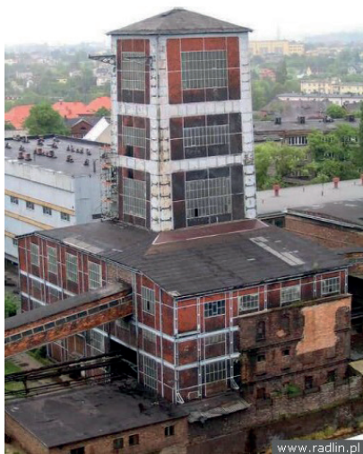
Wieża wyciągowa szybu "Wiktoria" kopalni "Emma"/"Marcel" w Radlinie, zrealizowana w oparciu o projekt Poelziga (wykonany dla kopalni "Rymer"), źródło: internet.
