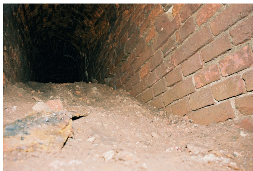
Fragment zaślepiętego murem kanału spalin grzewczych po byłym piecu wentylacyjnym, widoczne osmolone cegły.
