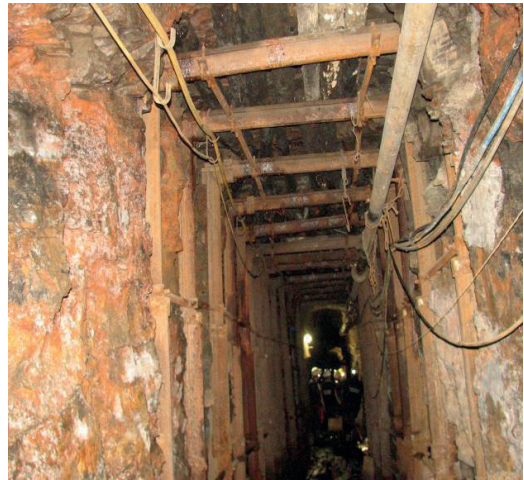
Rys. 6. Obudowa odrzwiowa ze stojaków SV zabudowana w wyrobisku z końca XVIII wieku
