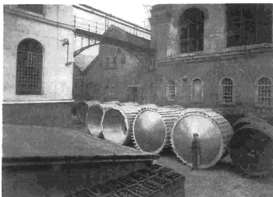
Aluminiowe zbiorniki dla browarów Wiednia z pocz. lat 20. XX w. produkowane na licencji firmy „Ziemann Feuerbach Stuttgart”, katalog „Öster. Industrierwerke”, prospekt z kolekcji Anny Warchałowskiej.
