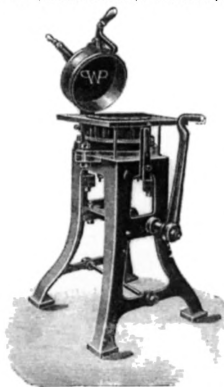
Maszyny do dzielenia ciasta, prasy ziemniaków, tarki suchych bułek, cukru, fig i innych produkowane w wielu typach i wielkościach, Katalog firmy „Werner und Pfleiderer”, Wien 1910.
