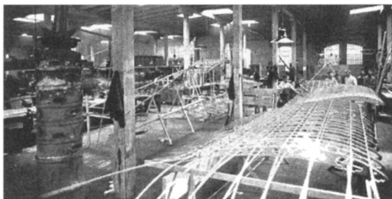
Budowa płatów nośnych w „Autoplanwerke”, Allgemeine Automobil Zeitung, nr 32 z 7.08.1910 s.2.
