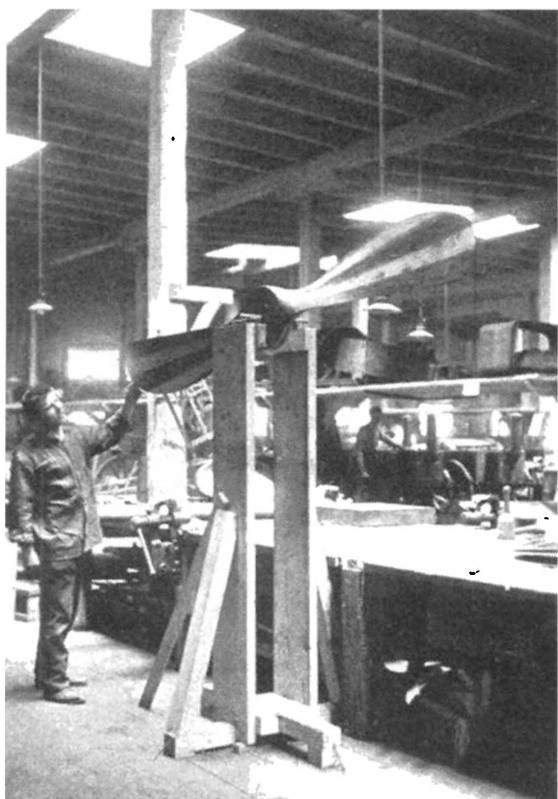
Technologia produkcji śmigieł lotniczych: 1. Wycinanie obrysu, 2. Klejenie warstw łopat śmigła, 3. Wykonywanie surowej formy śmigła, 4. Wykrawanie profilu łopat, 5. Wycinanie otworu na piastę śmigła, 6. Wyważanie śmigła, Allgemeine Automobil Zeitung, nr 32 z 7.08.1910 s. 3-6.
