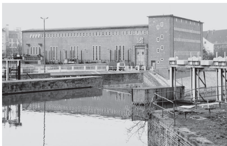
59. Elektrownia wodna Południe od dolnej i górnej wody, foto S. Januszewski
