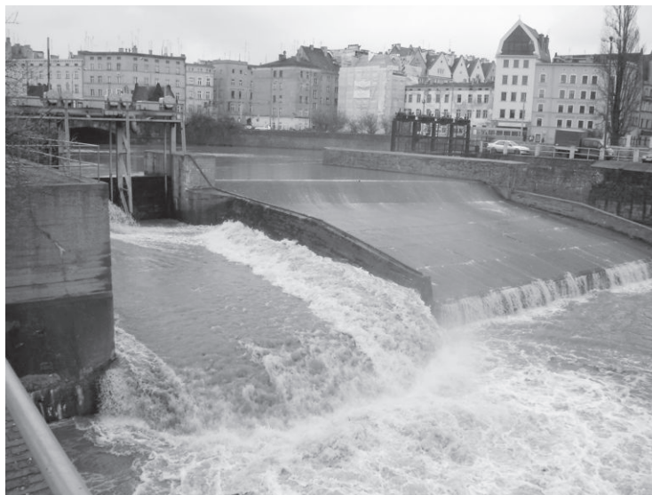
Jaz elektrowni wodnej Południe, foto P. Bakuliński
