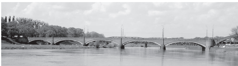
Mosty Warszawskie w dniach budowy i w roku 2005, foto S. Januszewski
