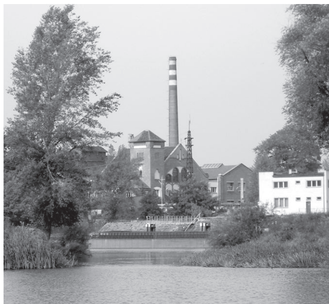
96. Przepompownia Ścieków Port, P. Bakuliński
