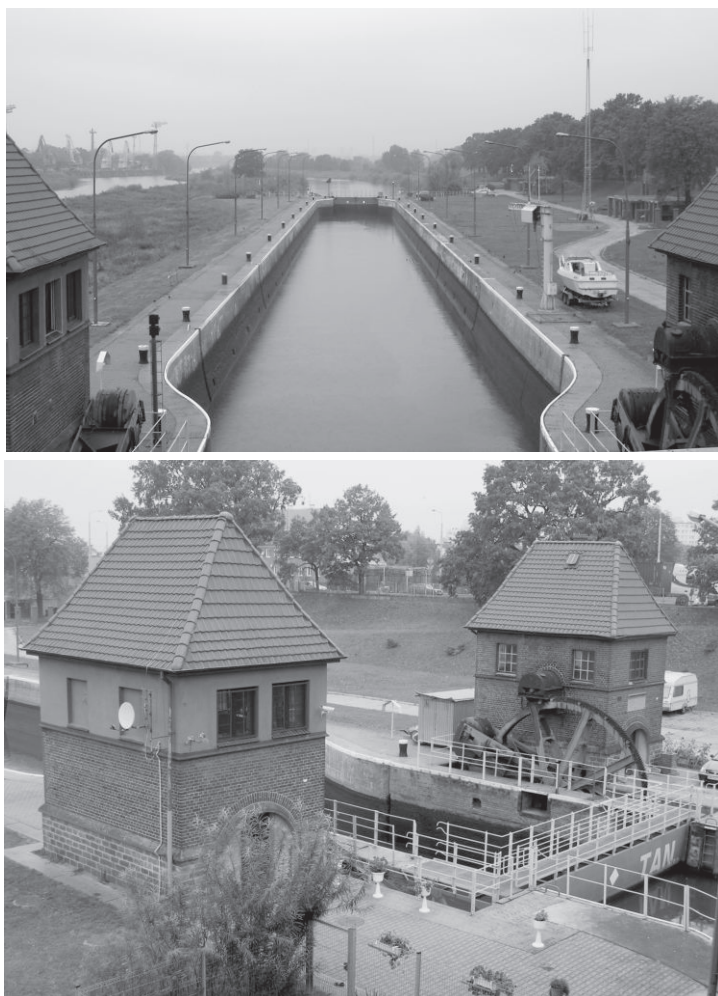
Komora śluzy Różanka, nastawnia, maszynownia oraz zamknięcie segmentowe głowy górnej, foto S. Januszewski
