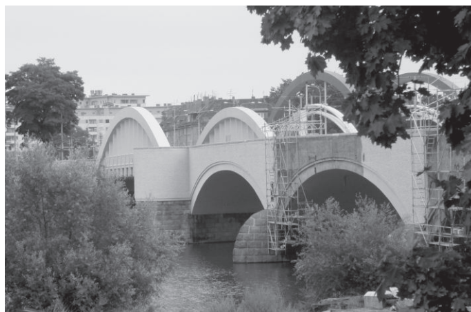
Budowa nowej nitki mostów Warszawskich, foto P. Bakuliński
