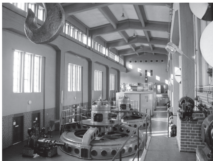
Wypożyczenie siłowni elektrowni wodnej Południe, na pierwszym planie dwa hydrozespoły systemu Francisa z 1923 r., foto S. Januszewski
