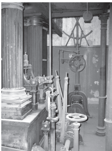
28. Agregaty pompowo-parowe Ruffera w maszynowni wieży ciśnien Na Grobli (1879), foto S. Januszewski
