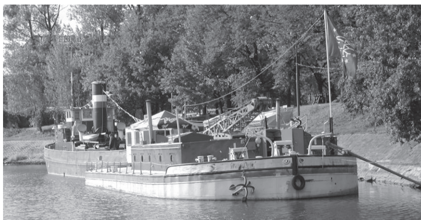
Dźwig pływający Wróblin na Odrze w 1958 r., foto M. Wróblewski i na stanowisku cumowniczym w awanporcie górnym Szczyczniki po odbudowie w 2002 r., foto S. Januszewski
