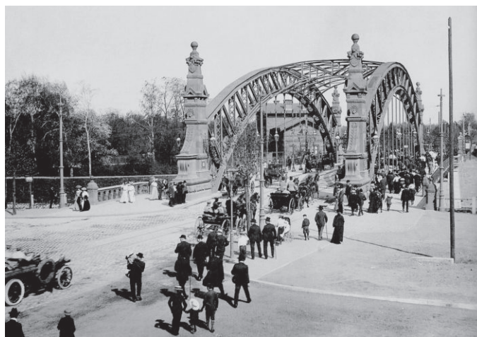
Budowa mostu Zwierzynieckiego i ruch na moście z pocz. XX wieku
