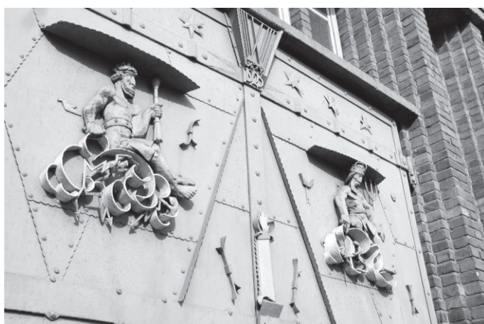
Elektrownia wodna Północ, foto S. Januszewski
