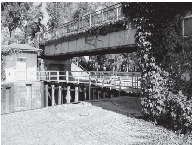
Śluza Rędzin II, komora, głowa górna i serwo mechanizm napędu wrót wspornych w maszynowni przy głowie, foto S. Januszewski
