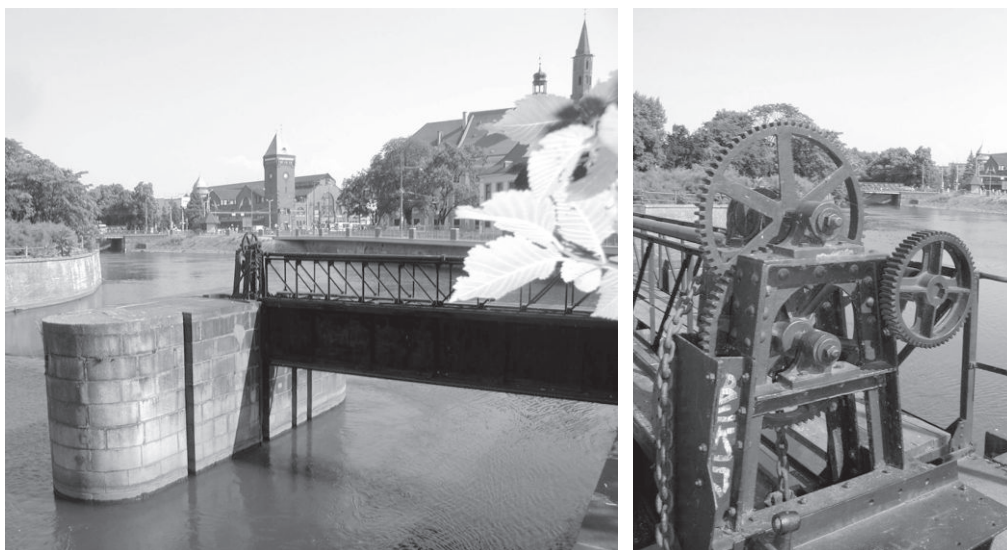
Jaz stały i zasuwowy Macieja z urządzeniem sterowania zasuwą, foto S. Januszewski
