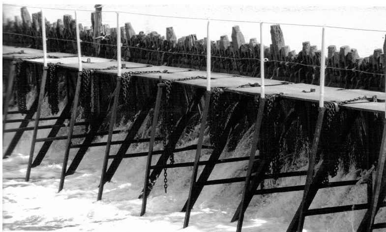
Jaz kozłowo-iglicowy typu Poiree. Widok od dolnej wody.
