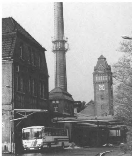
Wodociągowa wieża ciśnieniowa zakładów Ch.G. Dierig/Bielbaw SA z ok. 1900 r.
