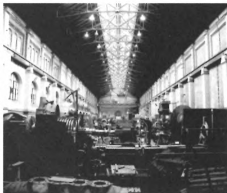
Wrocław, dawna maszynownia elektrowni miejskiej (później elektrociepłowni) przy ul. Łowickiej z 1901 roku
