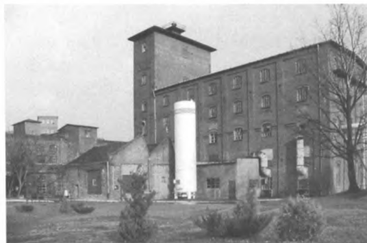
Ślad nie pozostał po zlikwidowanej przed kilku laty farbiarni z wieżowym zbiornikiem wody z 1909 roku
