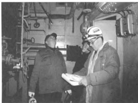
Kotłownia HP Nadbor. Inżynierowie Wojciech Śładkowski, Zbigniew Priebe i Jan Pietrasik dokonują oceny kotła parowego, 2009
