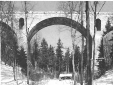
Wiadukt kolejki Sowiogórskiej w Srebrnej Górze, w dolinie Chłopiny, 1901
