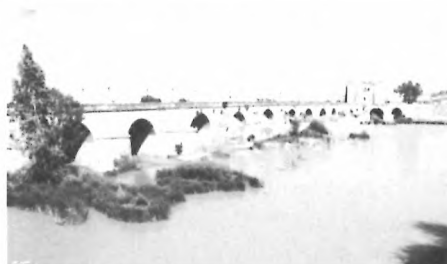
Cordoba (Hiszpania), kamienny, wielo- przęsłowy most rzymski z czasów Oktawia- na Augusta z I w.n.e. na rzece Gwadalkiwir, w IX w. przebudowany przez Arabów
