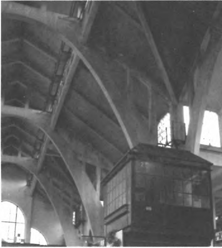
Wrocław, żelbetowy ustrój nośny Hali Targowej, 1904-1908
