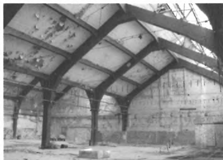
Zielona Góra, struktura wielonawowych hal wykańczalni tkanin i farbiarni dawnej Polskiej Wełny, 1921-1924
