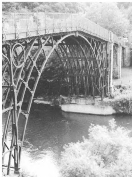
Pierwszy europejski most żeliwny na rzece Severn zbudowany przez Abrahama Darby III i Johna Wilkinsona – symbol angielskiej rewolucji przemysłowej, 1779
