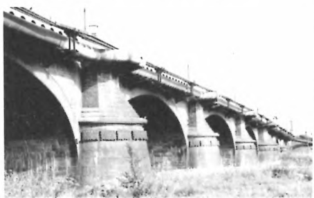
Most Osobowicki, wieloprzęsłowy, kamienny, sklepiony, 1897
