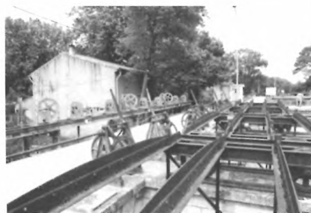
Wrota przeciwpowodziowe Libron na Kanale du Midi, 1681/1854
