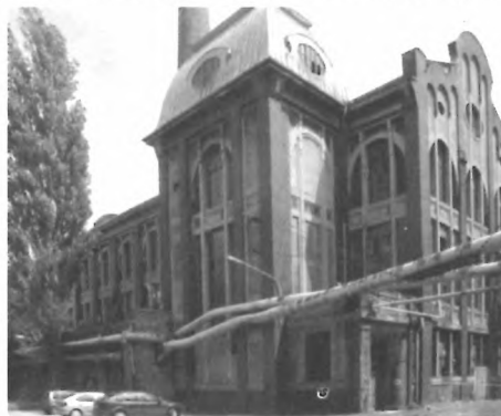
Łódź, elektrownia zakładów włókienniczych Scheiblera, pod historyzującym kostiumem kryjąca żelbetową konstrukcję, 1912
