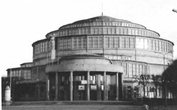
Żelbetowa hala Stulecia projektu Maxa Berga, Wrocław, 1913
