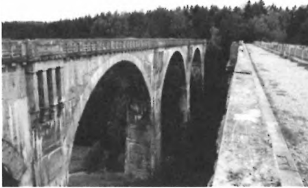
Wiadukty kolejowe w Stańczykach z 1914 i 1927 r.
