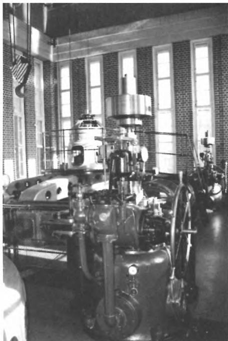
Hydrozespoły elektrowni wodnej Pótnoc, 1925
