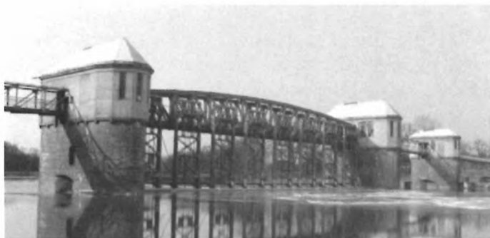
Jaz zasuwowo-segmentowy Rędzin z mostem jazowym, operacyjnym, 1917/1926
