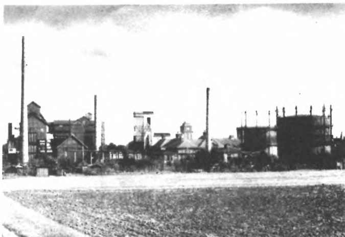
Gesamtansicht des Gaswerkes von Südost
