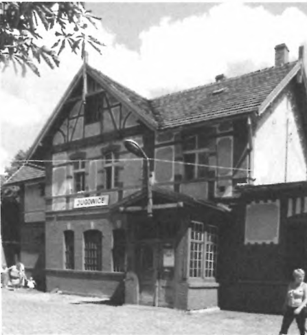
Dworzec kolejowy w Jugowicach, 1902-1904
