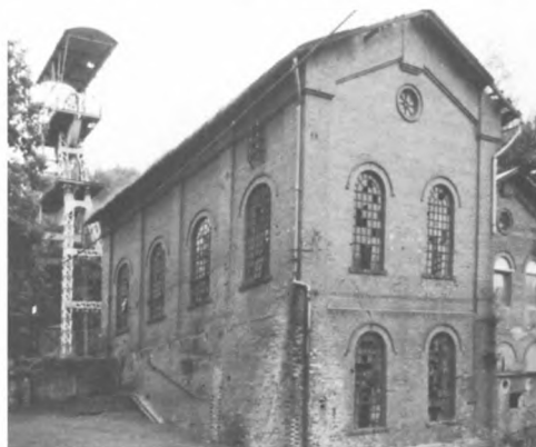
Nowa Ruda, zespół szybu Lech (stalowa, kozłowa wieża szybowa, maszynownia, kompresorownia), 1890
