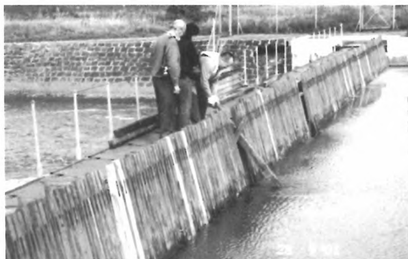
Jaz koźlowo-iglicowy Psie Pole systemu Poirée – ostatni tego typu na Odrze, 1897
