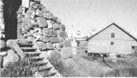
Zabudowa przemysłowa na Cyplu Śledzia – piwnica do impregnacji lin okrętowych i magazyn takielunku, ok. 1830/1840
