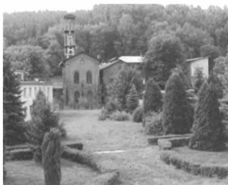
Nowa Ruda, zabudowa powierzchni szybu Lech, 1891/1914
