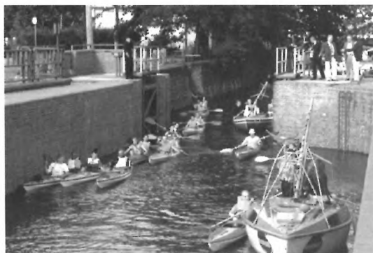
Śluza Mieszcząńska po remoncie prowadzonym w latach 1991-2000
