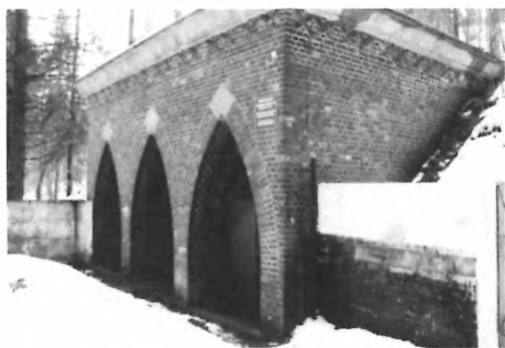
Bielawa, filtr powolny i zbiornik wody czystej drenażowego ujęcia wody, 1924-1928
