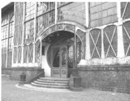
Dortmund, siłownia energetyczna szybów Zollern II/IV, 1904
