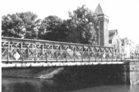
Most Piaskowy, model standardowego mostu kolejowego, stalowego, kratowego, przeniesiony na przeprawę drogową, 1861
