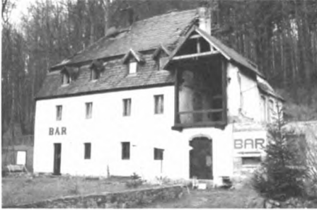
Budynek gwarectwa kopalń rudnych w Lubachowie/Złotym Lesie z 1783 r.
