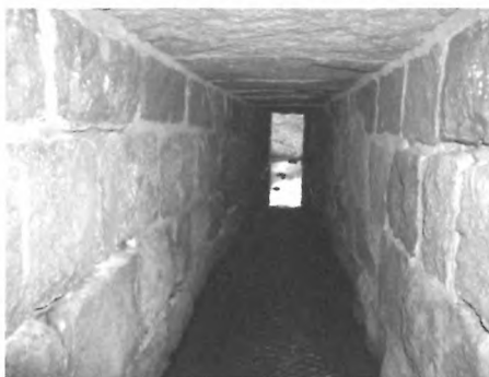
Przepusty wód pod linią kolejową Bystrzycką, 1902-1904
