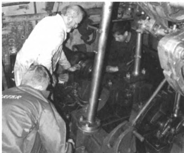
Wrocław, prace konserwacyjne w maszynowni, HP Nadbor, 2003
