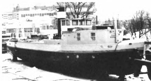
Prace stoczniowe Nadbora prowadzone w 1998/1999 we Wrocławskiej Stoczni Remontowej ODRA
