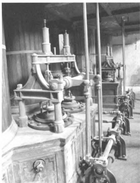
Agregaty pompowo-parowe z 1879 r., zbudowane we wrocławskich zakładach Ruffera, w maszynowni urządzonej w trzonie wodociągowej wieży ciśnień Na Grobli
