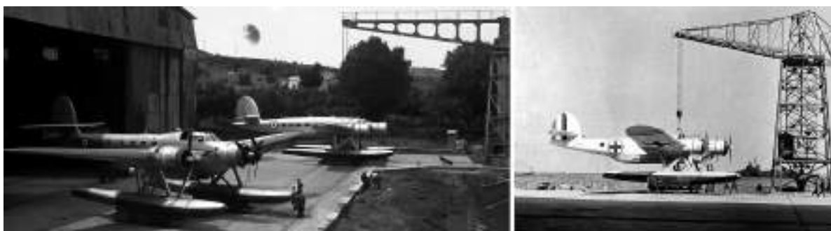
Włoskie samoloty torpedowe i transportowe Cant Z-506 B „Airone” na wózkach transportowych. Po prawej widoczny moment umieszczania hydroplanu na wózku za pomocą dźwigu.
