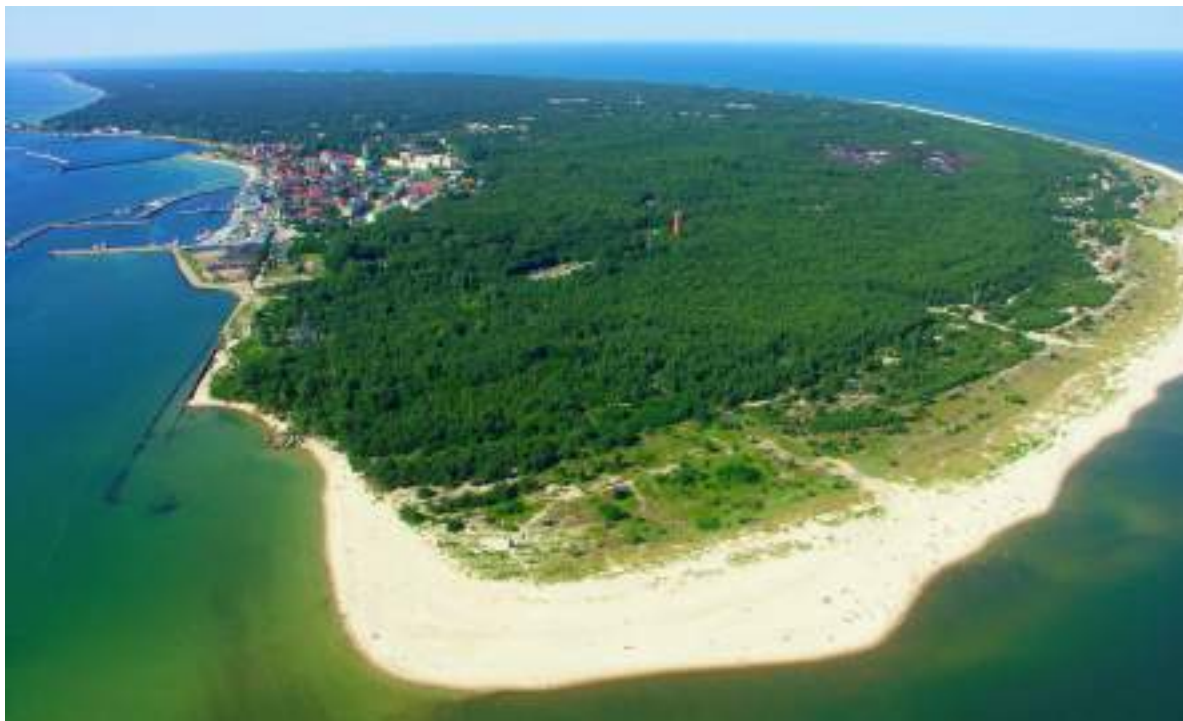
Las na końcu Półwyspu Helskiego jest pełen militarnych budowli.
