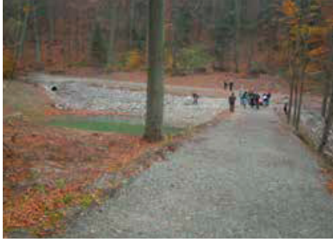
Widok na groblę i część odtworzonego, najwyżej położonego zbiornika nr 8 – będącego osadnikiem namulów przed kaskadą pozostałych, foto Ryszard Majewicz
