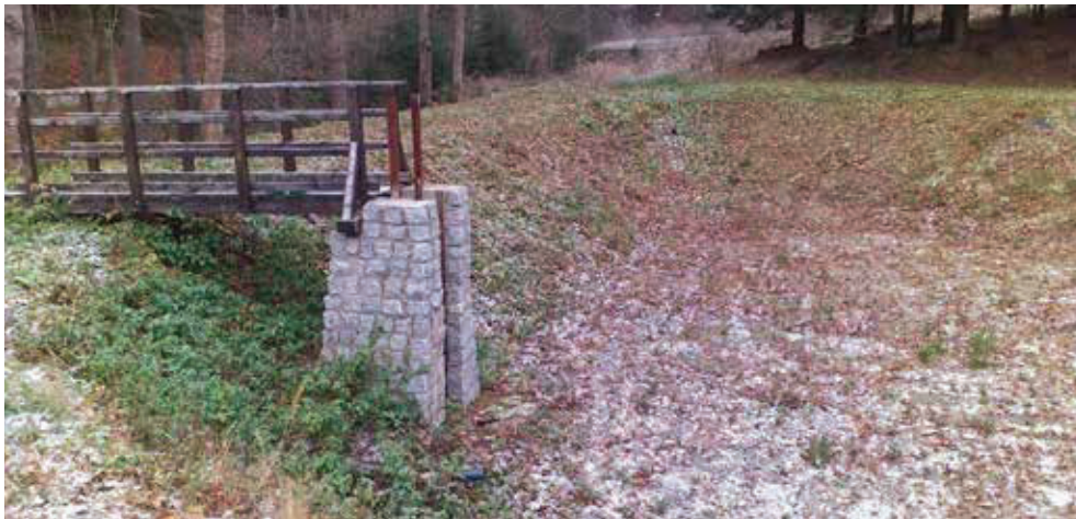
Wyremontowany zbiornik przed napełnieniem. Widok od strony wewnętrznej grobli czołowej w „górze” doliny – grudzień 2020 r., foto Kazimierz Jankowski, Nadleśnictwo Międzyzlesie.
