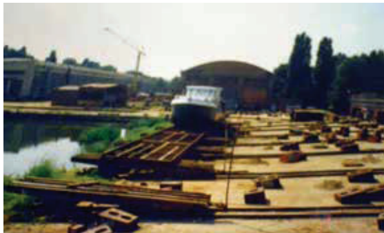
Jeden z ostatnich statków budowanych we wrocławskiej stoczni Zacisze, listopad 1994
