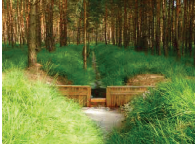
Jedna z 50-ciu zastawek drewnianych, zamontowanych na rowach leśnych w Nadleśnictwie Ruszów, w ramach systemu kompensacji ekologicznych budowy autostrady A-4, foto Jerzy Dauber
