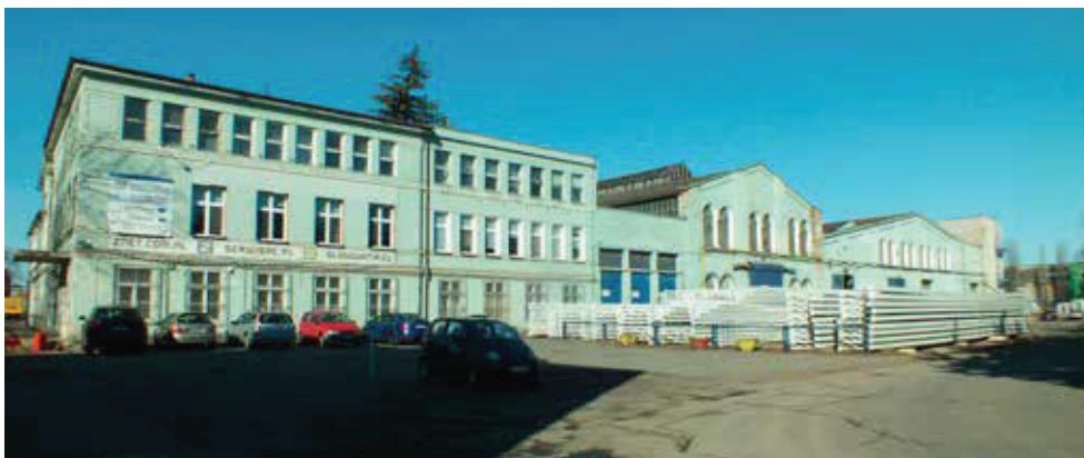
Elewacja wschodni hali kompleksu nr 11. Po lewej elewacja wschodnia budynku administracyjnego, foto W. Wrona Gaj, 03.2021 r.
