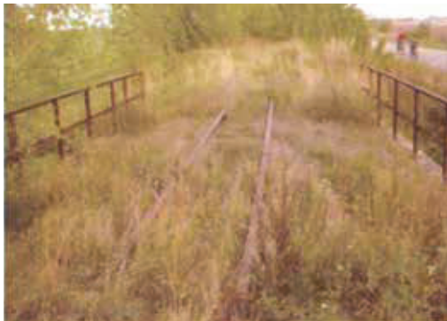
Przebieg linii wzdłuż drogi lokalnej w Słoniawach
