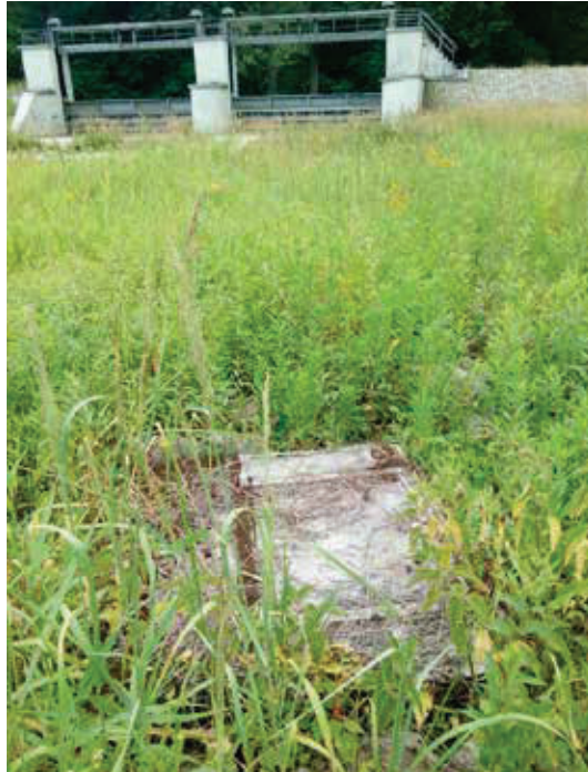
Widok budowli wlotowej od strony polderu (wody dolnej), foto Ryszard Majewicz.
