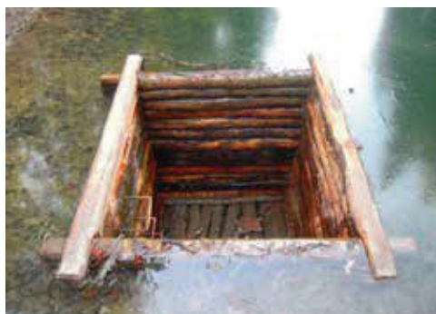
Drewniana, piętrząca studnia przelewową, foto Ryszard Majewicz
