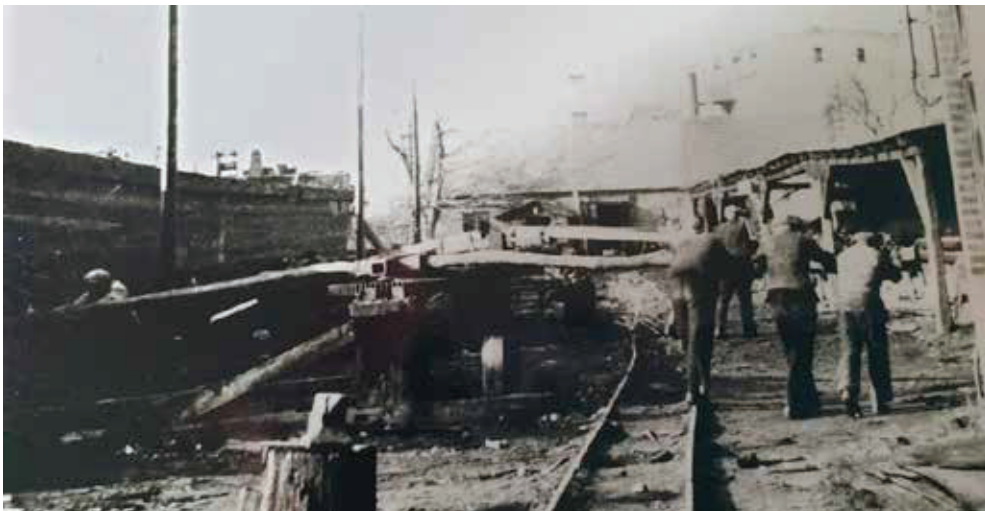
Kierat ręczny do wciągania barek na pochylnię remontową, foto Z. Walczak 1953
