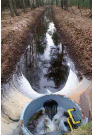
Działanie opóźniacza odpływu typu prof. Juliana Palucha - odpływ opóźniony na opóźniaczu: efektem retencji „liniowa” w rowie melioracyjnym i nawadnianie lasu (retencja gruntowa), foto Ryszard Majewicz
