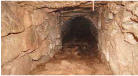
Ujawniony kanał pod korpusem (części ptn-zach.) grobli czolowej, foto Archiwum Nadleśnictwa Międzyzylesie
