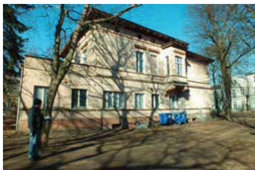
Elewacja wschodnia willi, foto W. Wrona Gaj, 03.2021 r.
