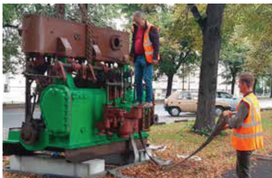
Prace konserwatorskie silnika parowego typu campound
