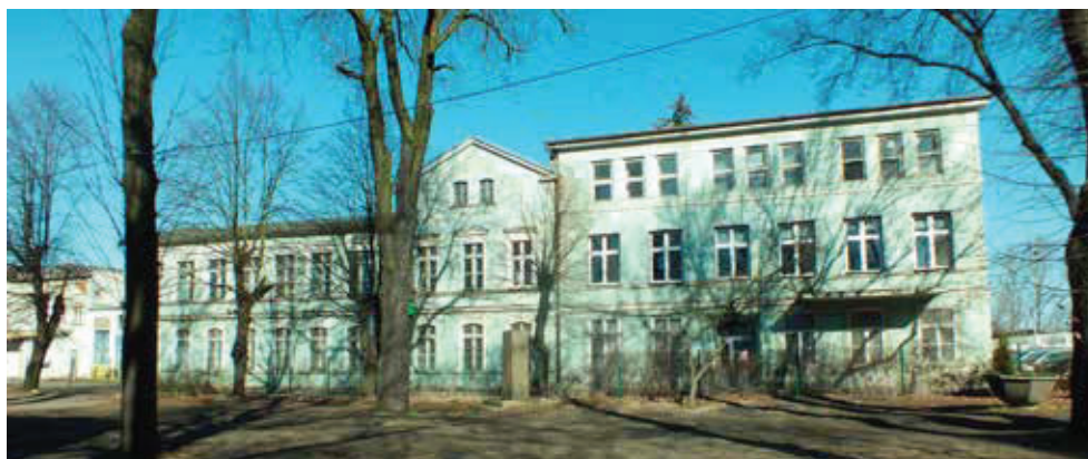
Budynek administracyjny od południa (fot. W. Wrona Gaj, 03.2021 r.)
