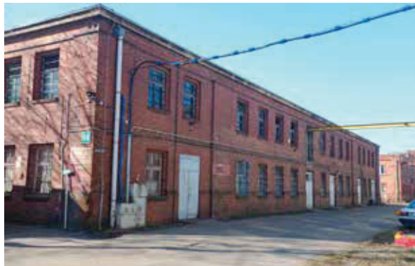
Magazyn I, elewacja północna, foto W. Wrona Gaj, 03.2021 r.
