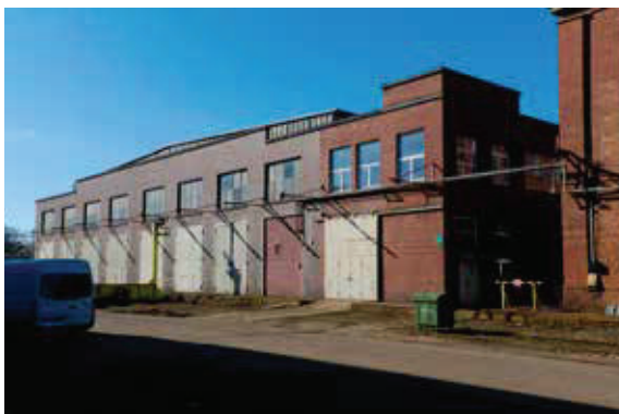
Elewacja wschodnia hali nr 21, foto W. Wrona Gaj, 03.2021 r.
