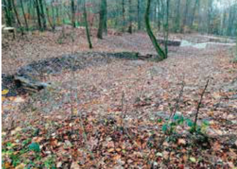
Odtworzona kaskada zbiorników wodnych w Nadleśnictwie Oborniki Śląskie. Najniższa część przelewów komunikacyjnych została wyłożona drewnianymi belkami. Dzięki temu przesączająca się woda nie przeszkadza, by na drugi brzeg przeprawić się „suchą stopą”. foto Ryszard Majewicz
