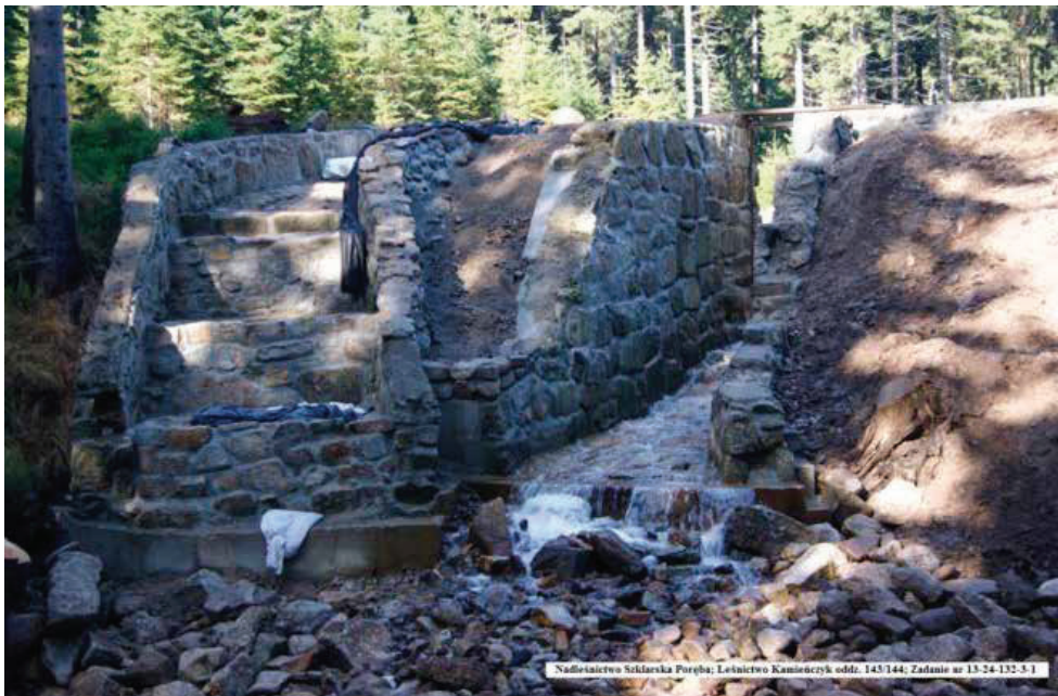
Odtworzony zbiornik z możliwością kontrolowanego poziomego piętrzenia, z przelewem bezpieczeństwa w obmurowaniach kamiennych, w Nadleśnictwie Szklarska Poręba, foto: Nadleśnictwo Szklarska Poręba.
