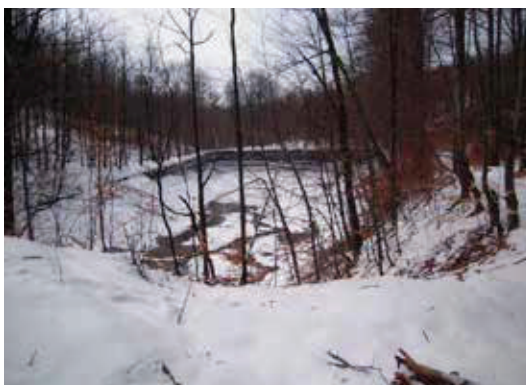
Groble piętrzące, skarpy i obrzeża zbiorników były porośnięte krzewami i drzewami, foto Ryszard Majewicz.
