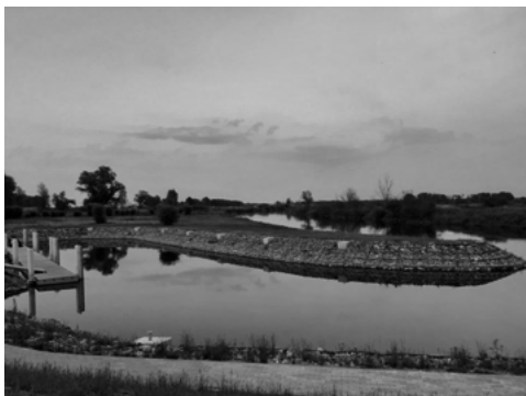
Marina Santoka w budowie
