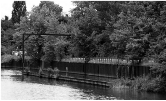
Port paliw płynnych przy Kanale Żeglugowym ok. 1980
