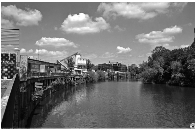
Nabrzeże w 2017 po katastrofie budowlanej
