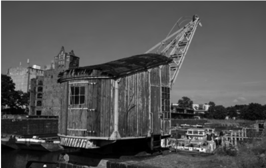
Żuraw portowy z 1901, pierwotnie parowy, później zelektryfikowany
