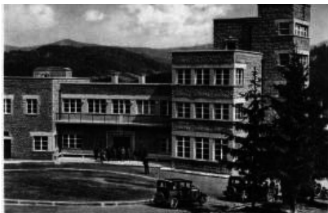
Zameczek zaraz po wybudowaniu – płaski dach
