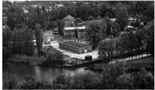
Basen portu paliw płynnych, 2005
