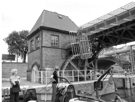
Śluza Różanka z zamknięciem głowy górnej podnoszonym segmentem, 1917
