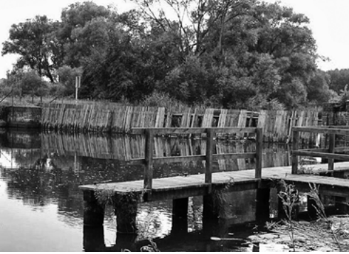
Jaz kozłowo-iglicowy w Neubrück. Fotografia z Wikipedii
