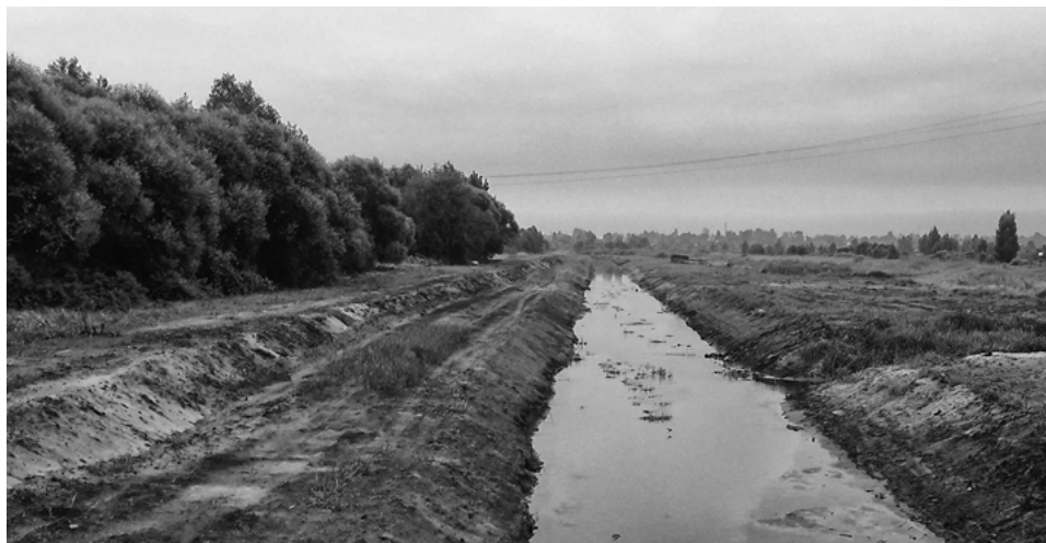
Fragment Kanału Ogińskiego po współczesnej melioracji (lipiec 2015 r.), około 2,5 kilometra na północ od Jasiołdy, przy służbie Nr 2 – hipotetyczny widok niegdyś nowo budowanego kanału w 1784 r.
