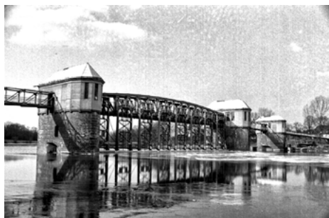
Rędzin – jaz segmentowo-zasuwowym z mostem jazowym, 1917
