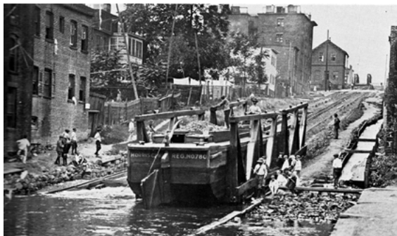
Archiwalne zdjęcie dolnego stanowiska pochylni Nr 12 East w Newark. Widoczne podwójne torowisko z dwoma wózkami. Przed budynkiem maszynowni i górnym wózkiem, prostopadle krzyżująca się z torami wspomniana ulica High Street – obecnie Dr. Martin Luther King Jr. Boulevard, źródło: J. Lee: The Morris Canal. A Photographic History...
