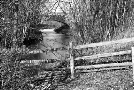
Most w Dobrzykach na drodze Zalewo – Susz oraz Iława. Stan aktualny
