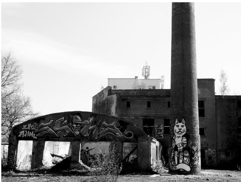
Kotłownia z kominem. Fot. M. Wesołowska
