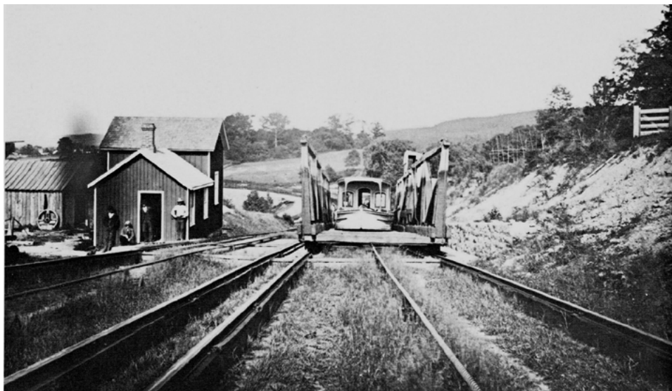
Widok pochylni Nr 6 West w Port Colden na przełomie XIX i XX w. Wyraźnie widoczne podwójne torowisko szyn z podłużnymi podkładami oraz stalowa lina pociągowa. Sceneria zadziwiająco przypominająca pochylnie wschodniopruskie, źródło: J. Lee: The Morris Canal. A Photographic History...
