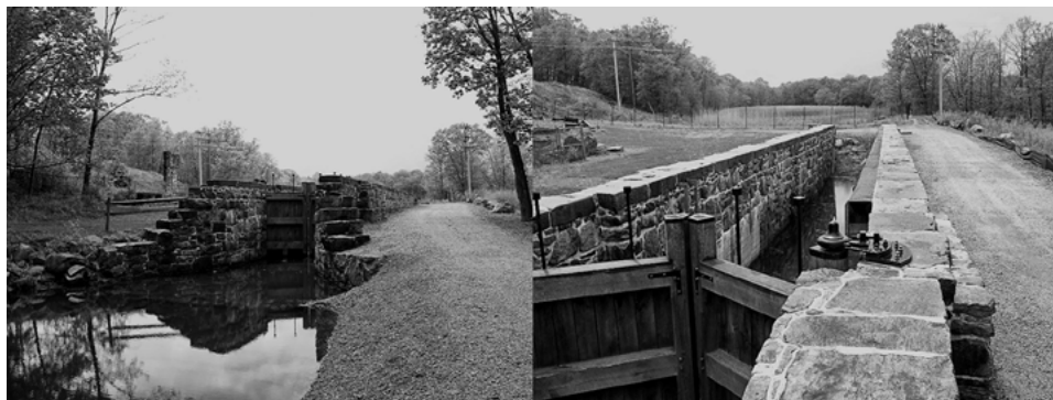
Jedyna istniejąca, odbudowana i zrekonstruowana współcześnie budowla wodna na Kanale Morris – śluza Nr 2 East w Wharton. Widok w maju 2019 r, źródło: archiwum autora
