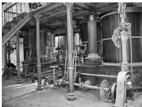
Cylindry i systemy sterowania maszynami parowymi wieży ciśnień Na Grobli, 1879
