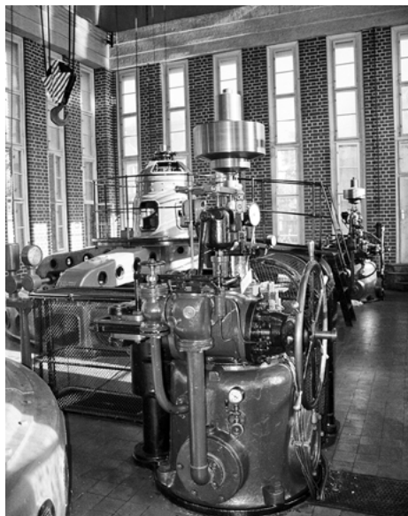
Elektrownia wodna „Północ”, 1925
