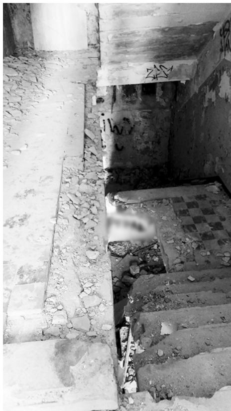
Klatka schodowa budynku biurowego. Fot. M. Wesołowska
