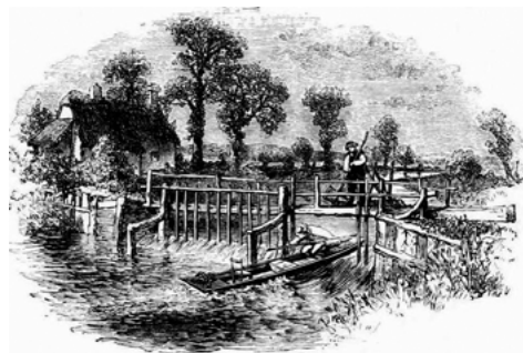
XIX wieczny jaz na Tamizie w Halt z bramą umożliwiającą przepłynięcie łodzi
