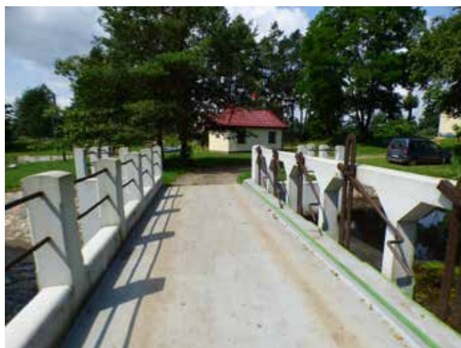
Dźwigniowe mechanizmy wyciągowe zastawek jazu Zielona o napędzie ręcznym, foto S. Januszewski
