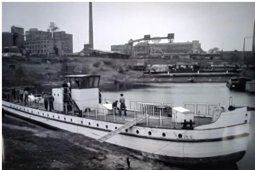
Podczas remontu l. 70. XX wieku
