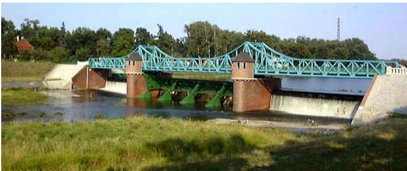
Jaz Bartoszowice z zamknięciem segmentowym widok od dolnej wody; nad jazem – most jazowy.
