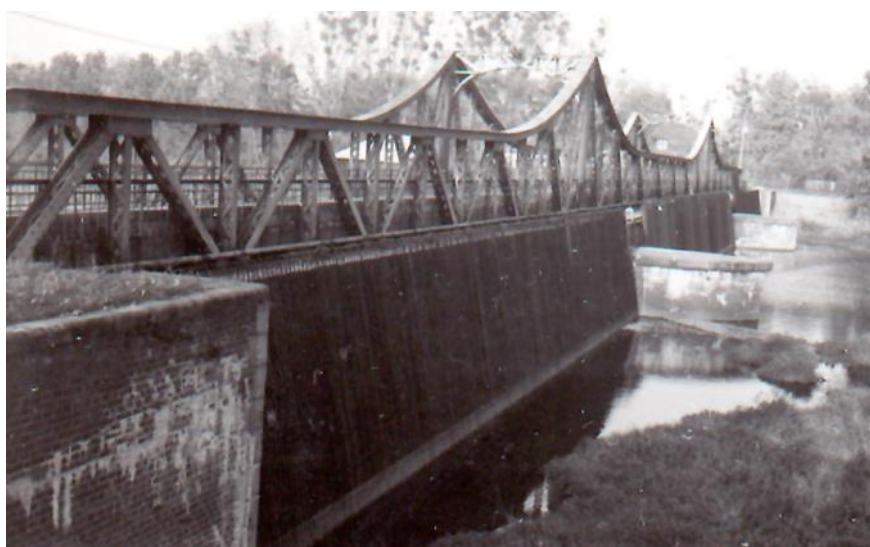
Jaz Bartoszowice z kompletnym zamknięciem iglicowym nowego typu od wody górnej – widok z brzegu lewego kanału powodziowego. Iglice są opierane o krawędź stałej kładki roboczej wyposażonej w tzw „grzebień”.
