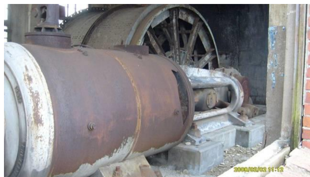
Relikty maszyny wyciągowej
