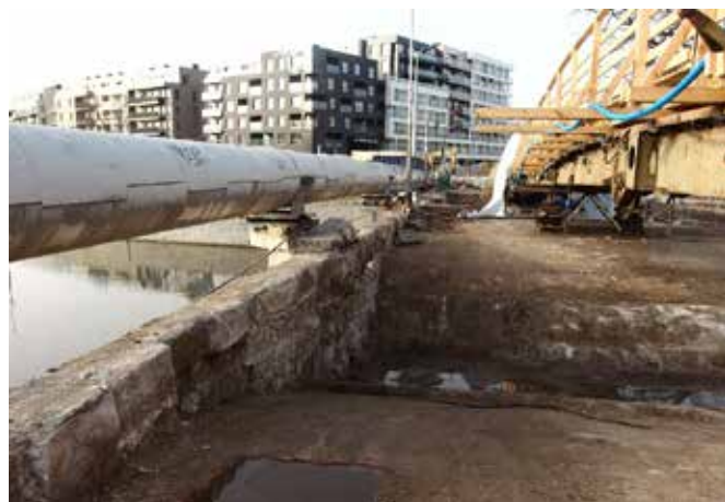
Rys. 5. Odslonięte przęsał mostu południowego.
