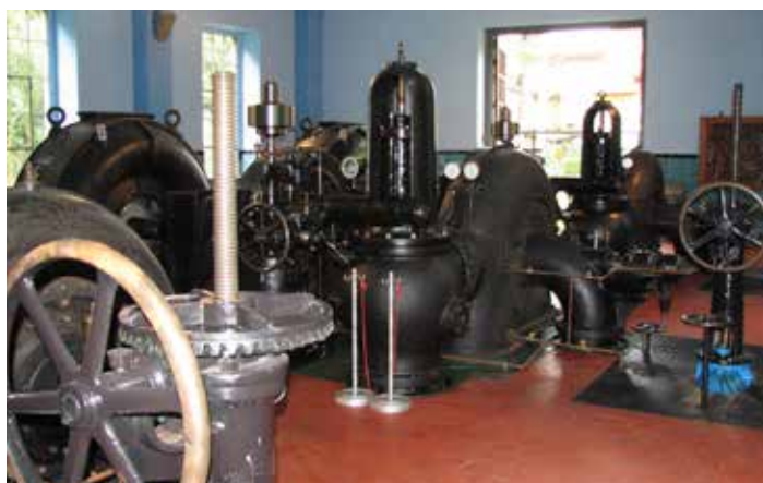
Hydrozespoły..Elektrownia wodna Lubachów.8.09.07.
