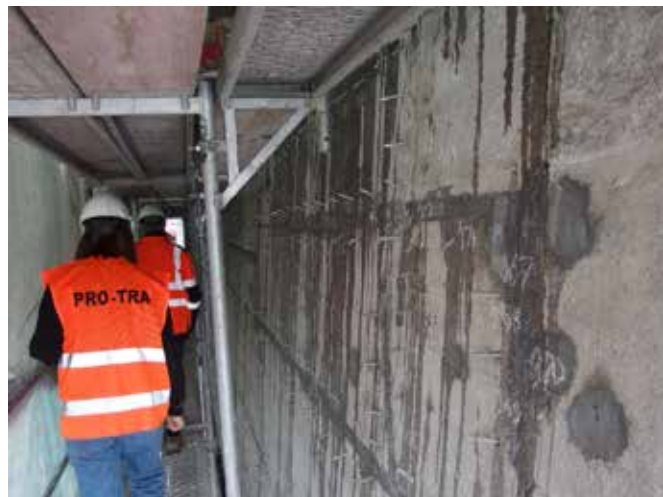
Rys. 8. Uszczelnienie i wzmocnienie spękanych podpór betonowych mostu północnego.
