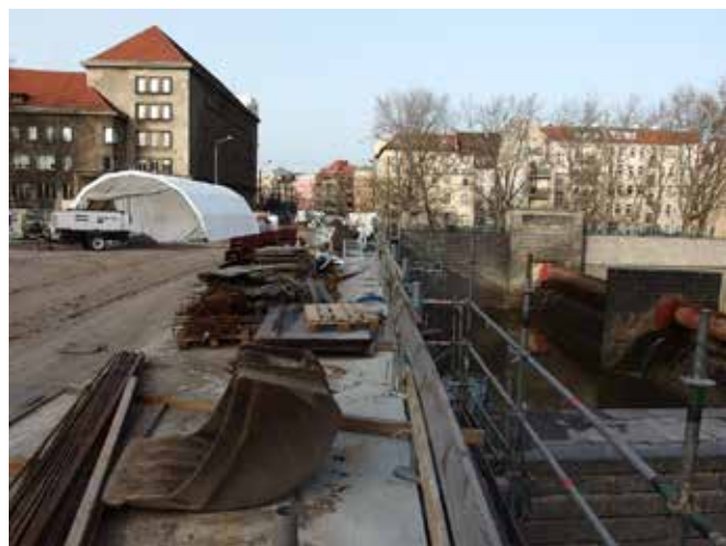
Rys. 9. Nowa płyta pomostowa mostu północnego stanowi zaplecze do remontu pozostałych mostów
