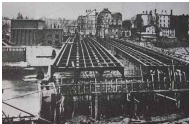
Budowa mostu Pomorskiego Północnego, 1929 r, widok od północy (Maciej Łagiewski, Mosty Wrocławia, Ossolineum, 1989 r.)
