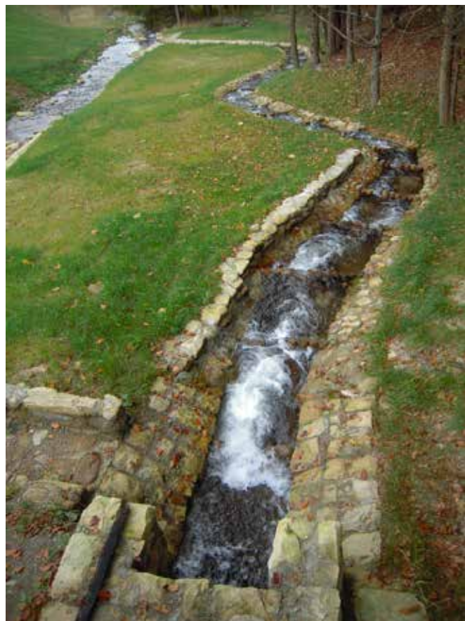
Widok na przeplawkę z zapory. Fot.: Ryszard Majewicz.
