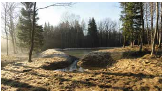
Kałuża ekologiczna, zbiornik i grobla piętrząca zbiornika z przelewem bezpieczeństwa. Fot.: Ryszard Majewicz
