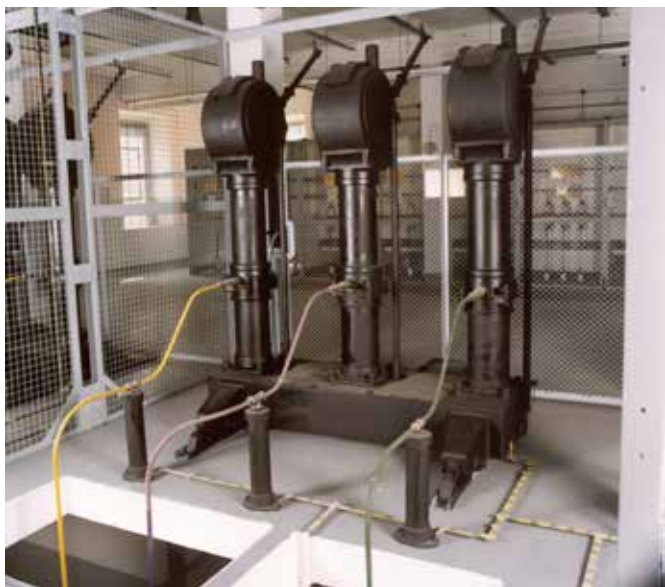
Odłączniki mechaniczno-hydrauliczne SSW w rozdzielni, 1913.
