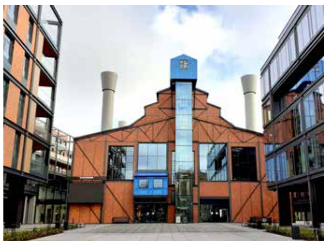
Zrewitalizowana hala maszyn elektrowni wraz z dobudowanymi apartamentowcami.
