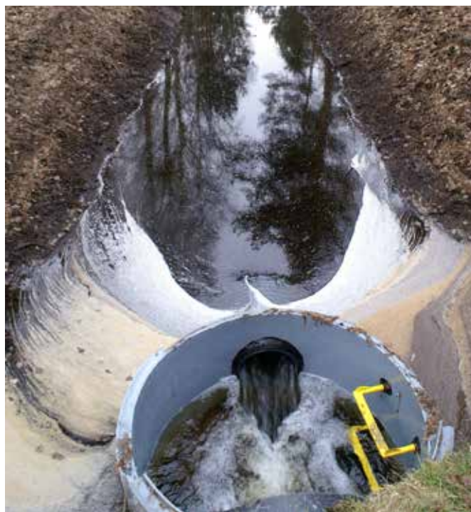
Odpływ opóźniony na opóźniaczu - retencja „liniowa” w rowie melioracyjnym i nawadnianie lasu (retencja gruntowa). Fot.: Ryszard Majewicz
