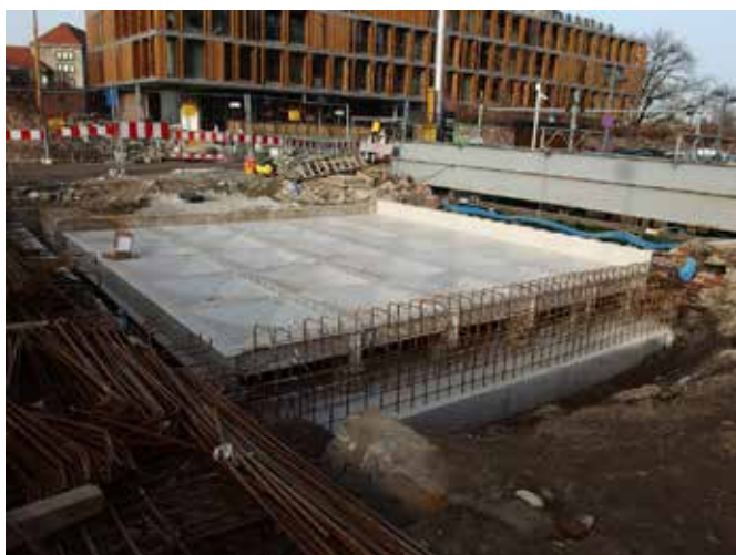
Rys. 6. Wyremontowane prześło wschodnie mostu środkowego.
