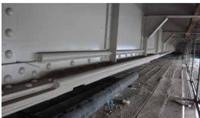
Rys. 7. Wzmocnione w 1954 r. prześła mostu północnego.
