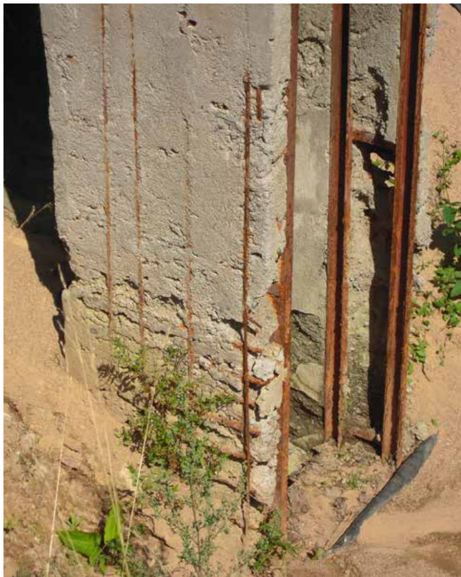
Stan wyrodowania dolnej części konstrukcji żelbetu mnicha – widok od strony wody górnej. Fot. Ryszard Majewicz
