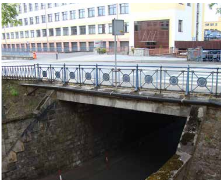
Zakłady CELMA. Widoczny przejazd technologiczny z barierami.
