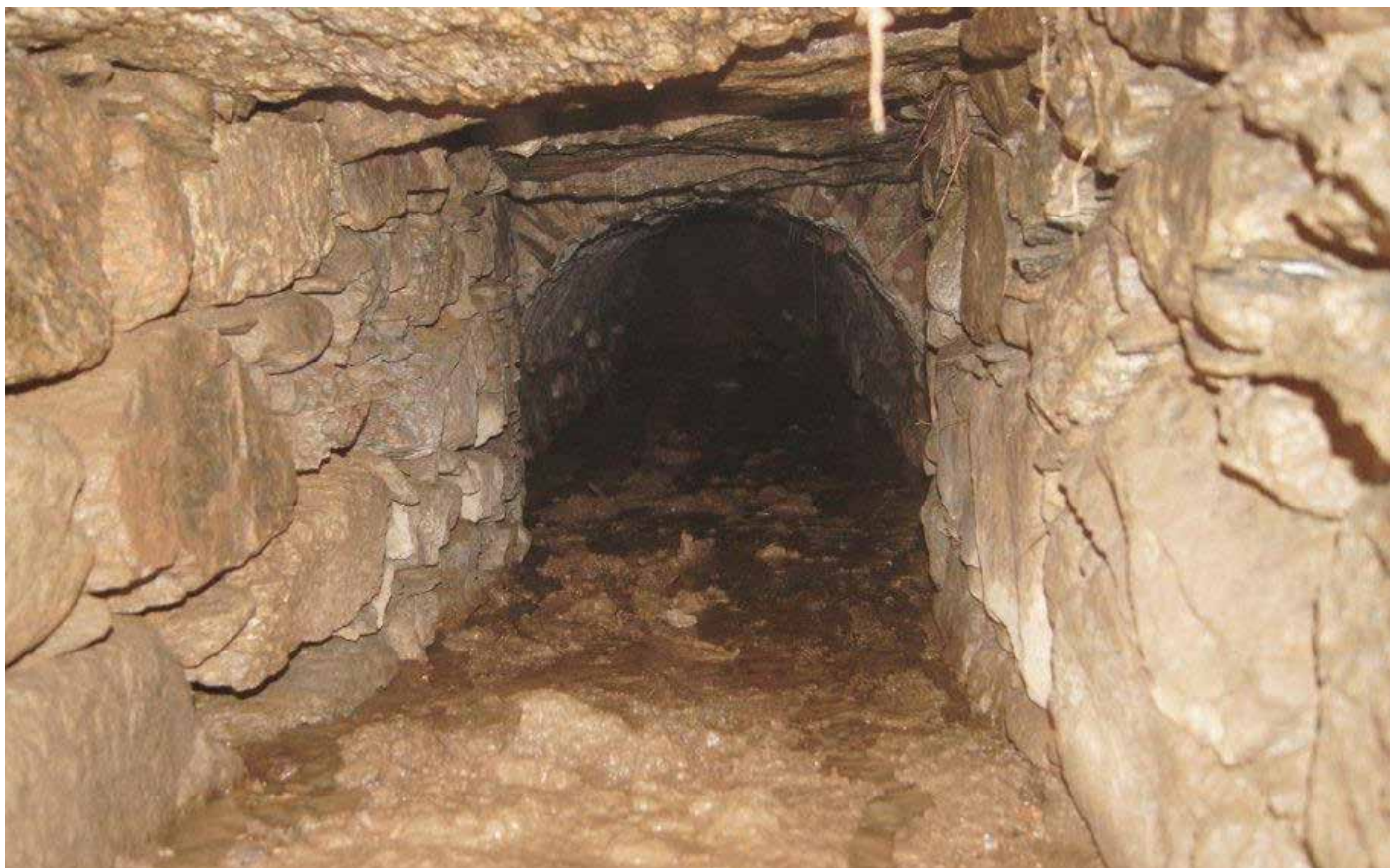
Ujawniony kanał pod korpusem (części płu-zach.) grobli czołowej. Fot.: Archiwum Nadleśnictwa Międzylesie .
