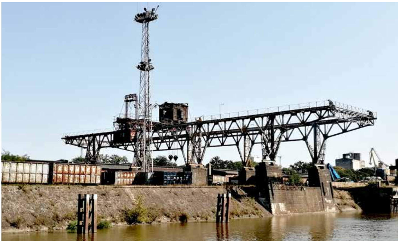
Port Miejski Zabytkowa suwnica 1910.
