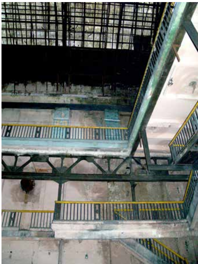
Galerie i schody w hali kotłów
