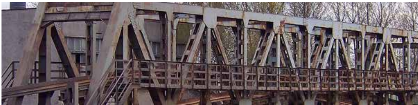
Zdjęcie mostu zsykowego przy szybie Poniatowski
