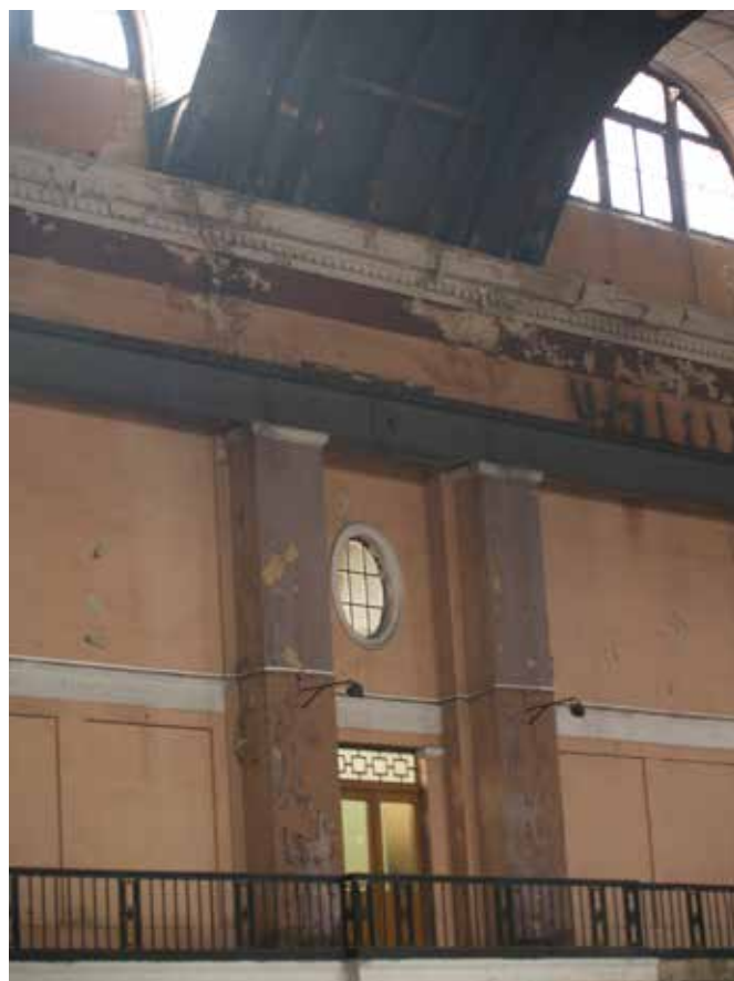
Sala z modrzewiowym sufitem = odpadające tynki w hali maszyn
