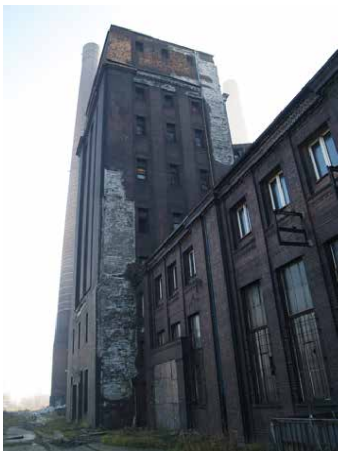
Odpadający klinkier ze ścian
