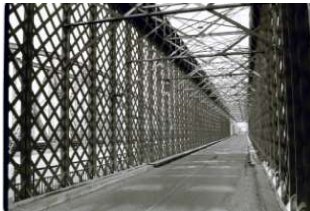
Siatka kratownicy mostu „rurowego”
