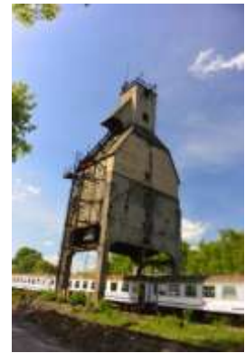
Wieża do nawęglania parowozów w Krakowie-Prokocimiu, stan obecny źródło: Wikimapia.org, autor nieznany
