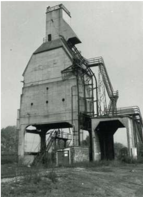
Wieża do nawęglania parowozów i napełniania piaskiem piasecznic przy parowozowni Warszawa Odolany. Rok 1982. Fot. Jerzy Szeliga, ze zbiorów Cyfrowej Stacji Muzeum
