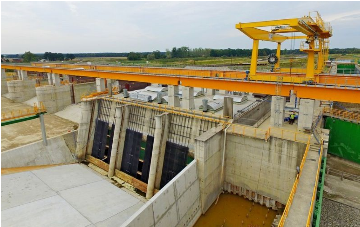
Suwnica bramowa jazu, elektrowni i dolnych wrót śluzy oraz przęsła jazu ruchomego od górnej wody podczas budowy.
