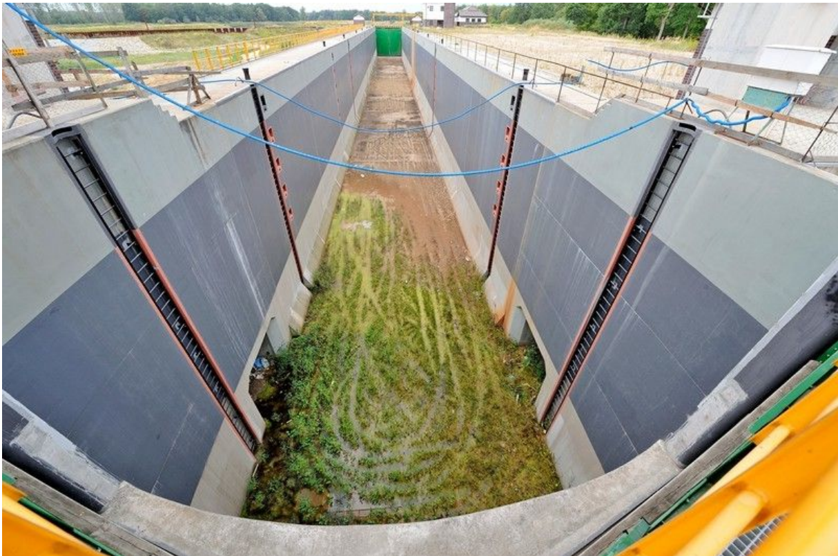
Komora śluzy od górnej wody podczas budowy.
