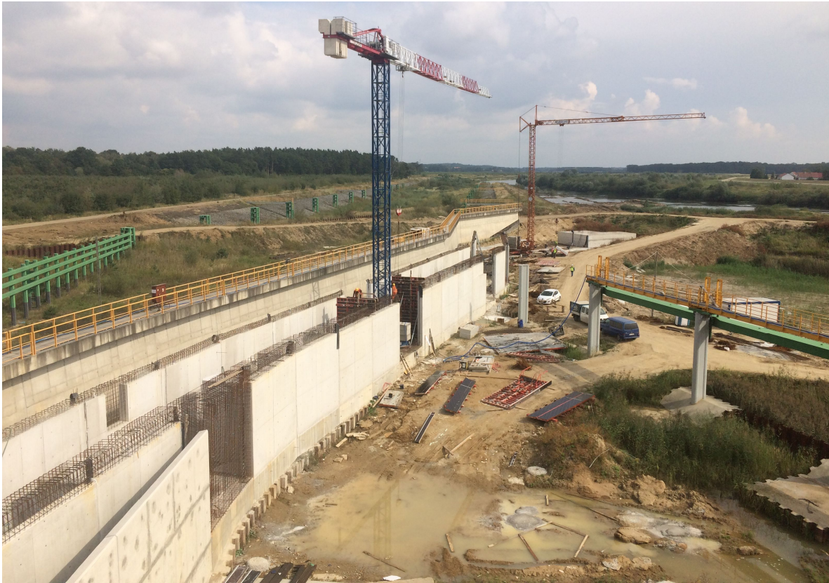
Budowa przepławki III (dla ryb dwuśrodowiskowych) od dolnej wody.
