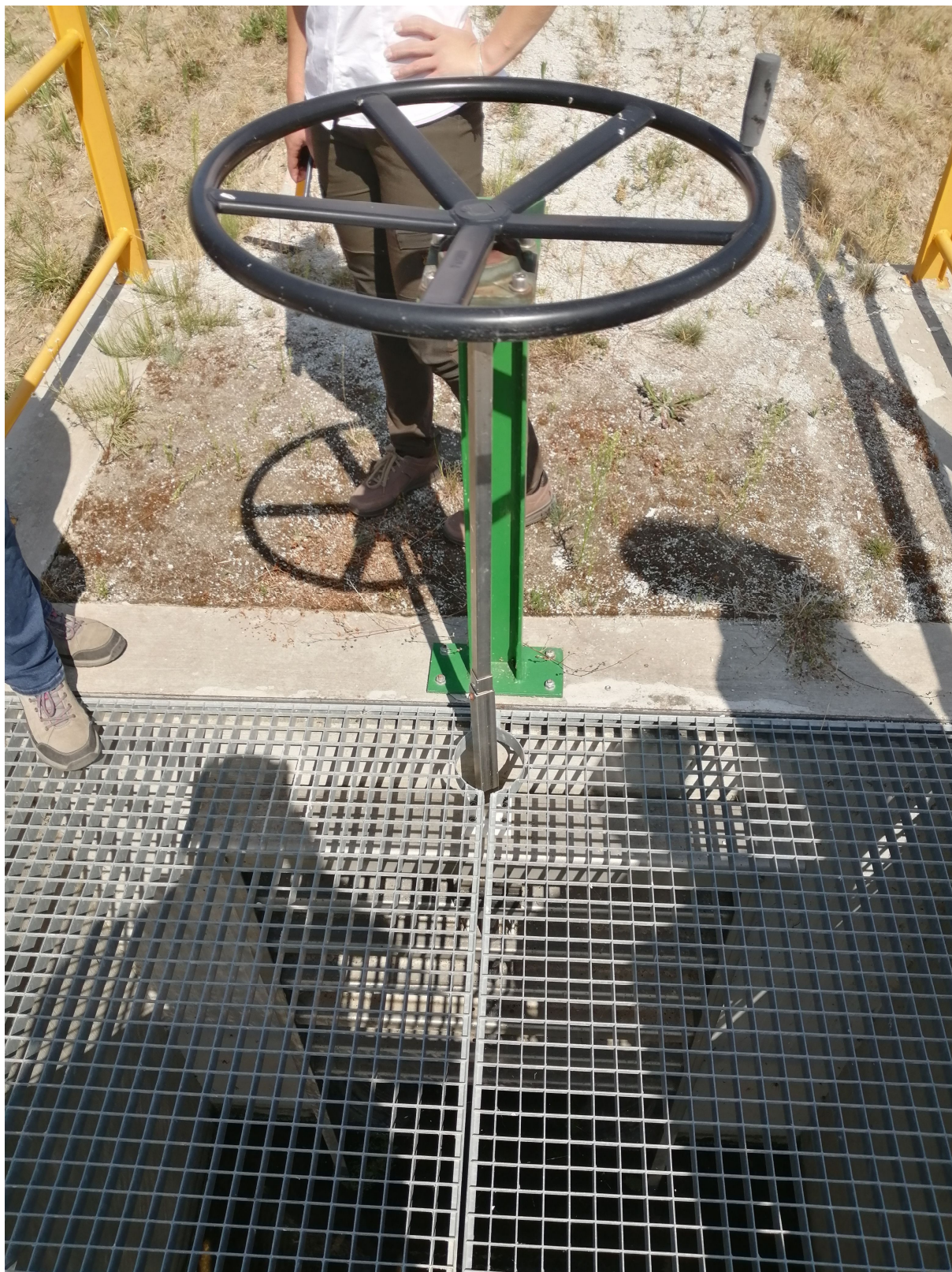
Zasuwa na wlocie do zbiornika wyrównawczego (na prawym brzegu śluzy – widok od górnej wody).
