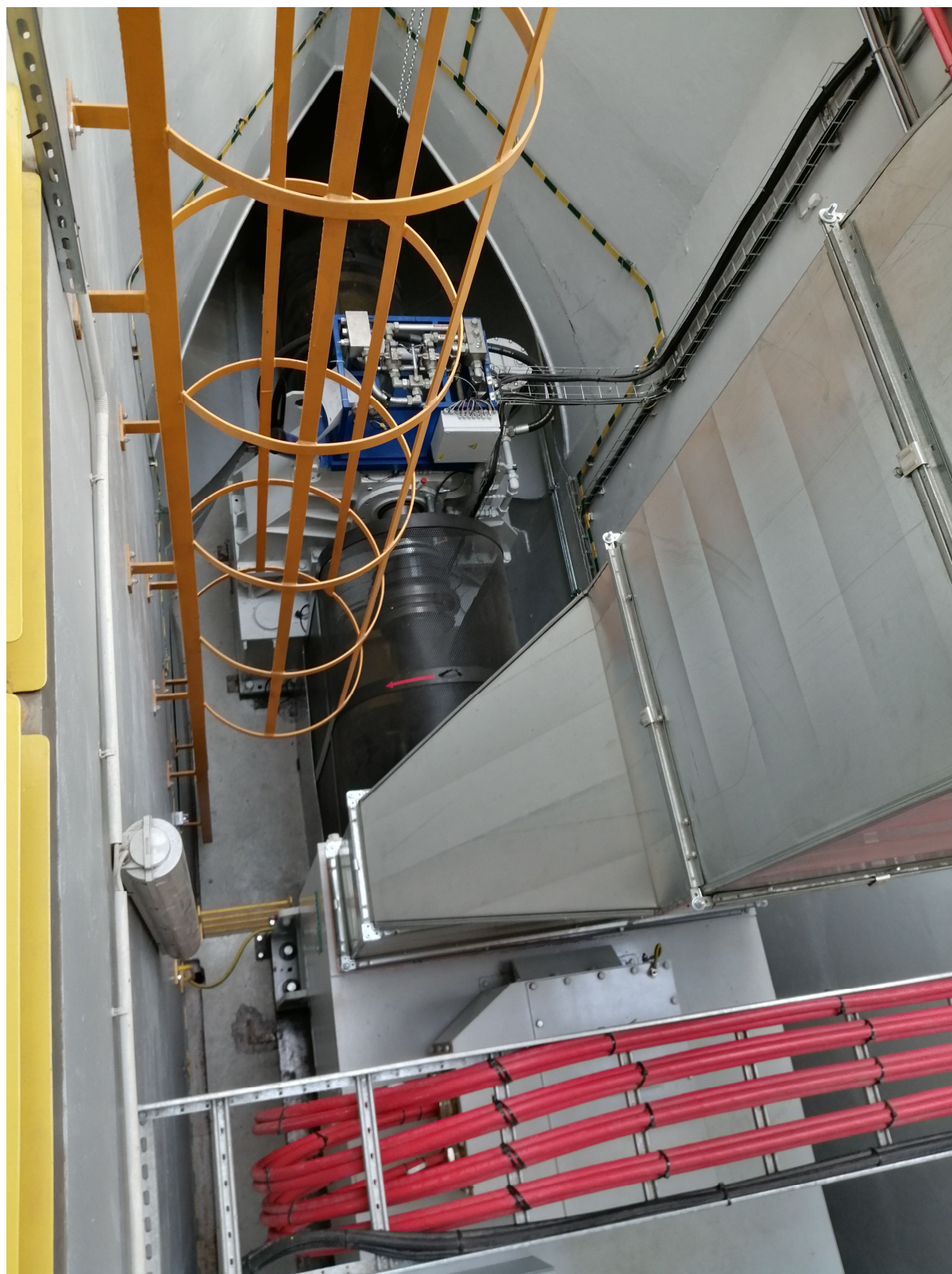
Pracująca turbina elektrowni wodnej.
