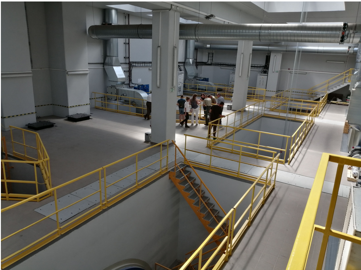
Hala turbin elektrowni wodnej.
