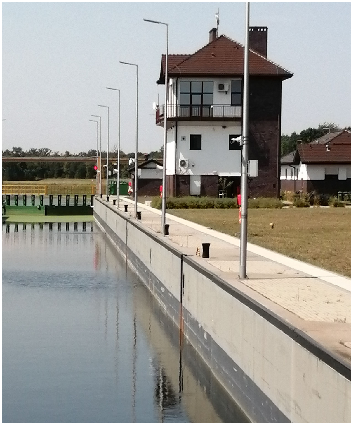
Sterówka, maszynownia wrót dolnych (prawych) i budynek magazynowy.
