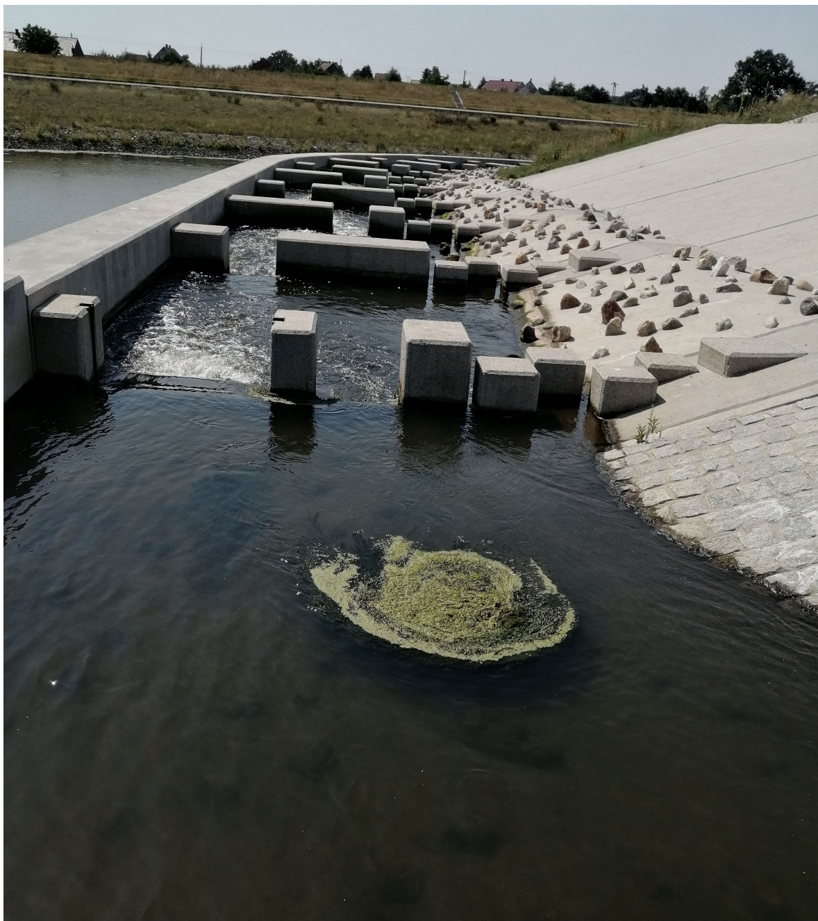
Wlot wody do przepławki II.
