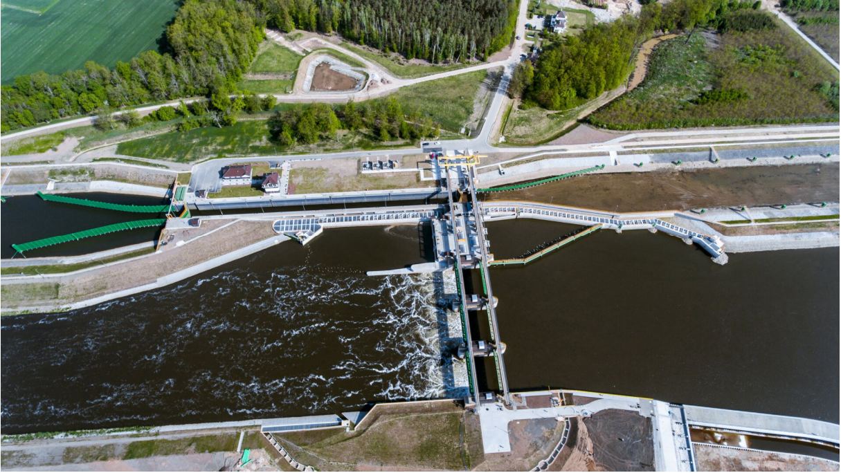
Zbiornik wyrównawczy (na prawym brzegu, na wysokości śluzy) podczas budowy.
