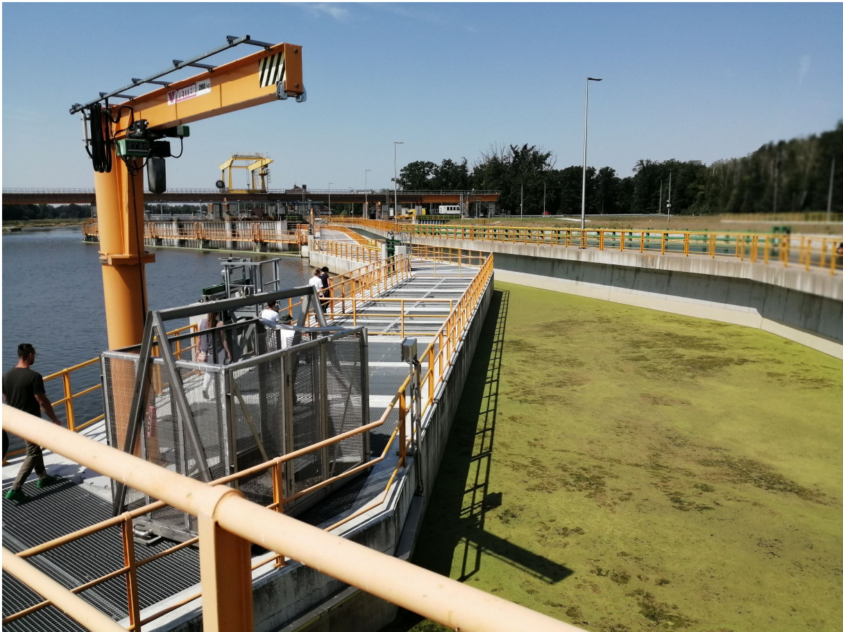
Górna (wlotowa) część przepławki III (dla ryb dwuśrodowiskowych) oraz kanał wlotowy do elektrowni wodnej od górnej wody.
