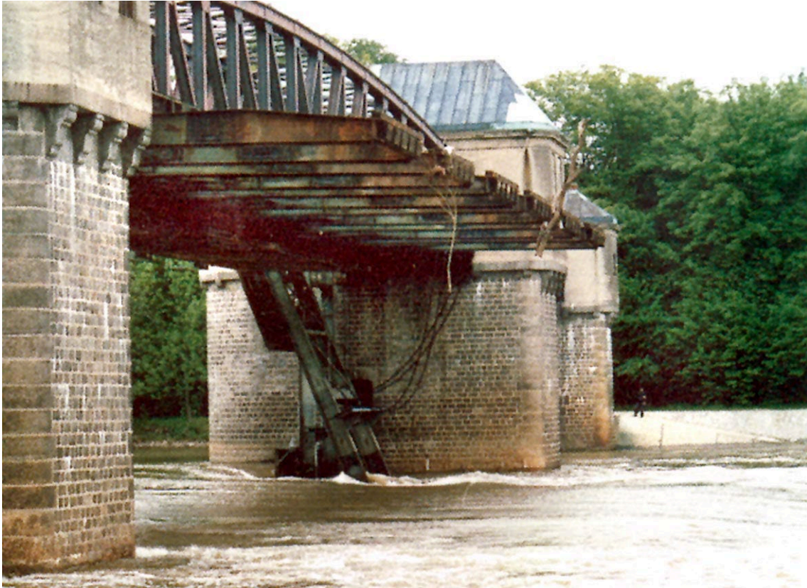
Jaz segmentowo – zasuwowy Rędzin podczas podnoszenia odrzwi (z podniesionymi zasuwami) pod mostem jazowym nad przęsłem środkowym.
