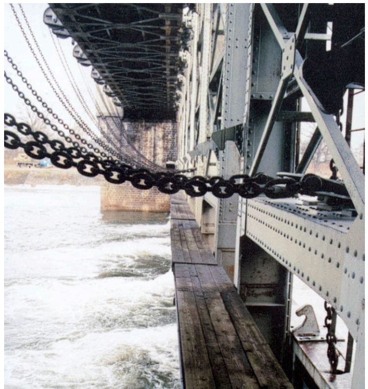
Jaz segmentowy – zasuwy Rędzin. Widok z pod mostu na odrzvia i zasuwy – także na łańcuchy do ich podnoszenia oraz na kładkę roboczą.
