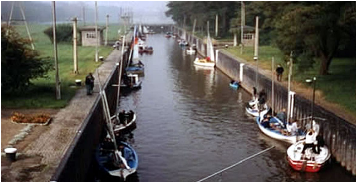
Komora śluzy „larsenowej” – widok z mostu nad głową górną.
