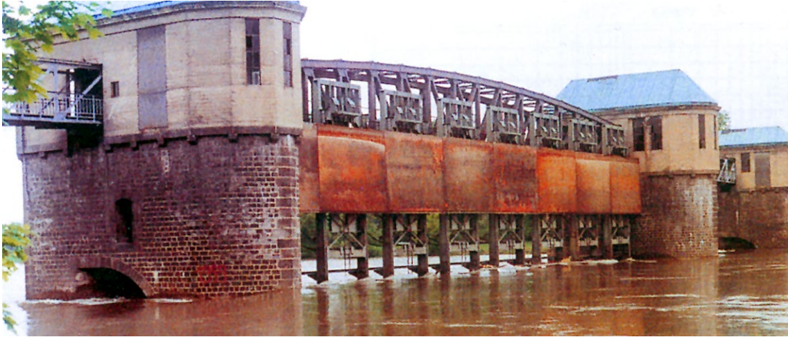
Jaz segmentowo – zasuwowy Rędzin podczas przepuszczania wód powodziowych (położone segmenty, podniesione zasuw) – widok od górnej wody.
