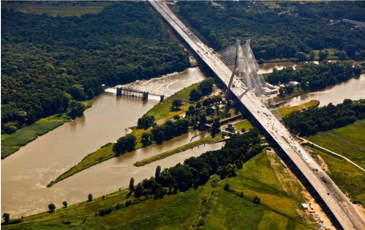
Budowa mostu obwodnicy autostradowej Wrocławia nad stopniem wodnym Rędzin.
