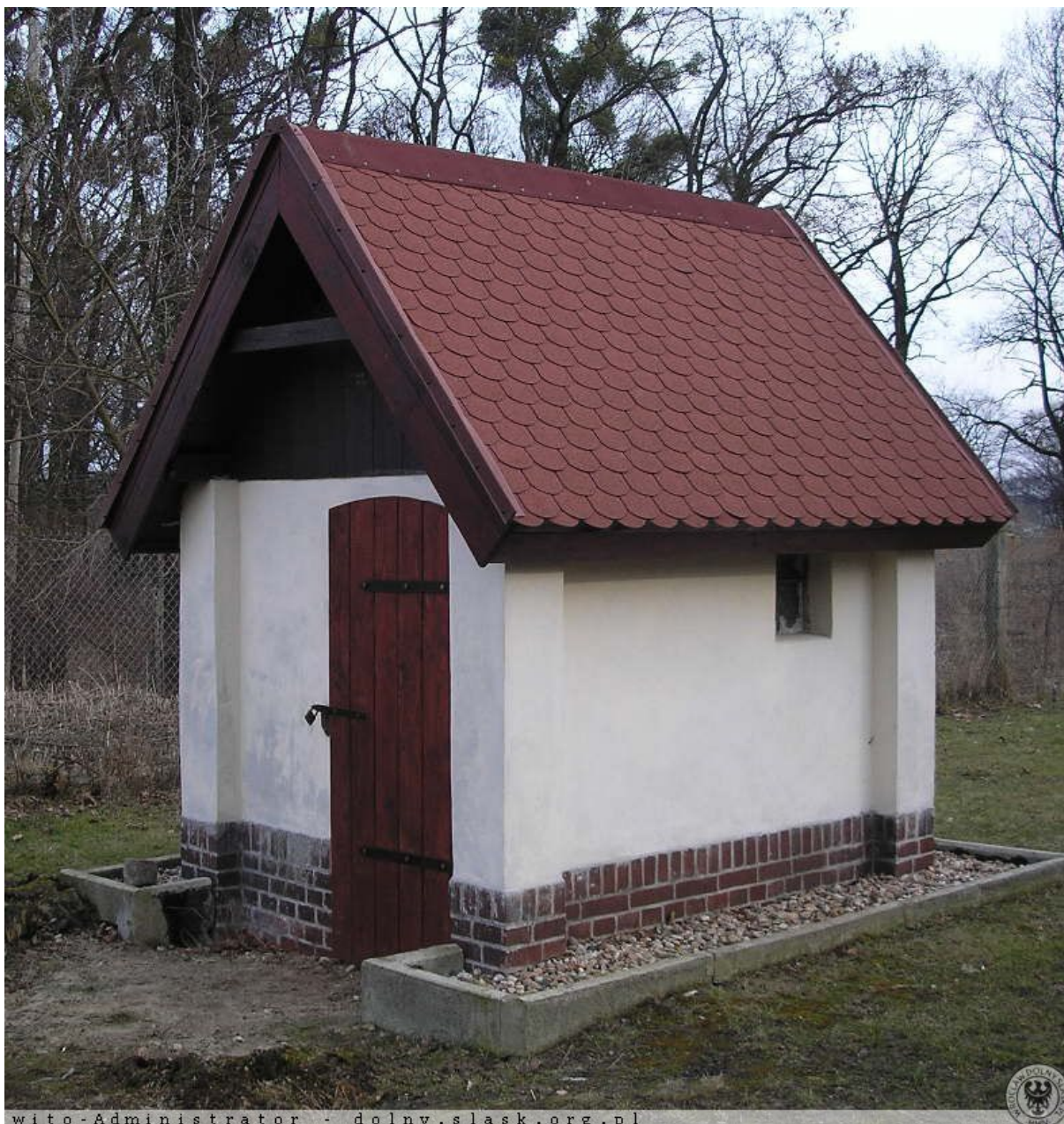
Szalet przy pierwotnej sterówce śluzy – miejscu pracy kierownika Śluzy po remoncie. 2009 r.
