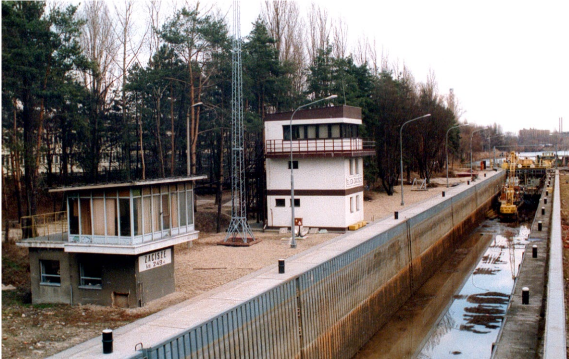
Odpompowana z wody komora śluzy z nową prawą ścianą larsenową, sterówką z lat 70-tych i najnowszą sterówką z lat 90-tych XX wieku.
