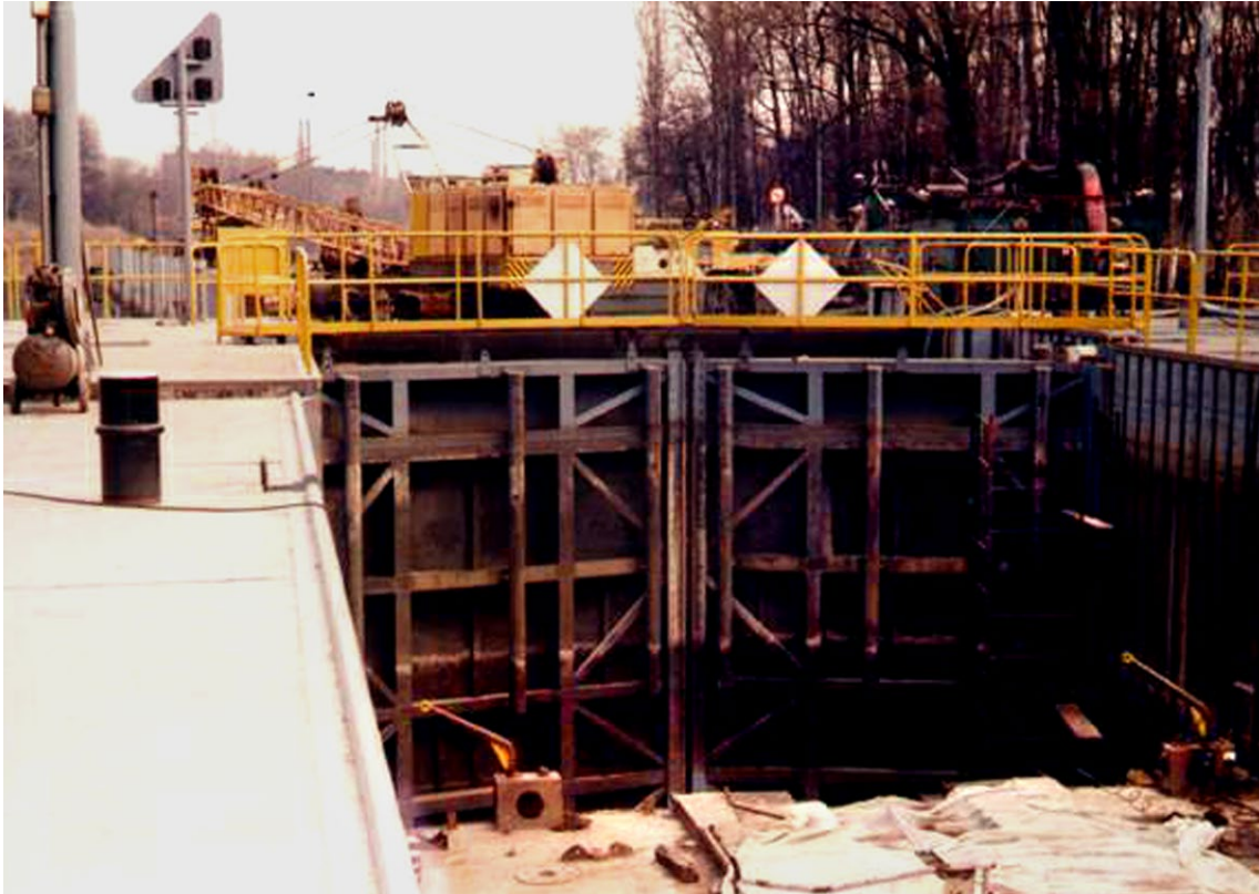
Wrota górne śluzy od strony (odpompowanej z wody) komory śluzy w czasie remontu.
