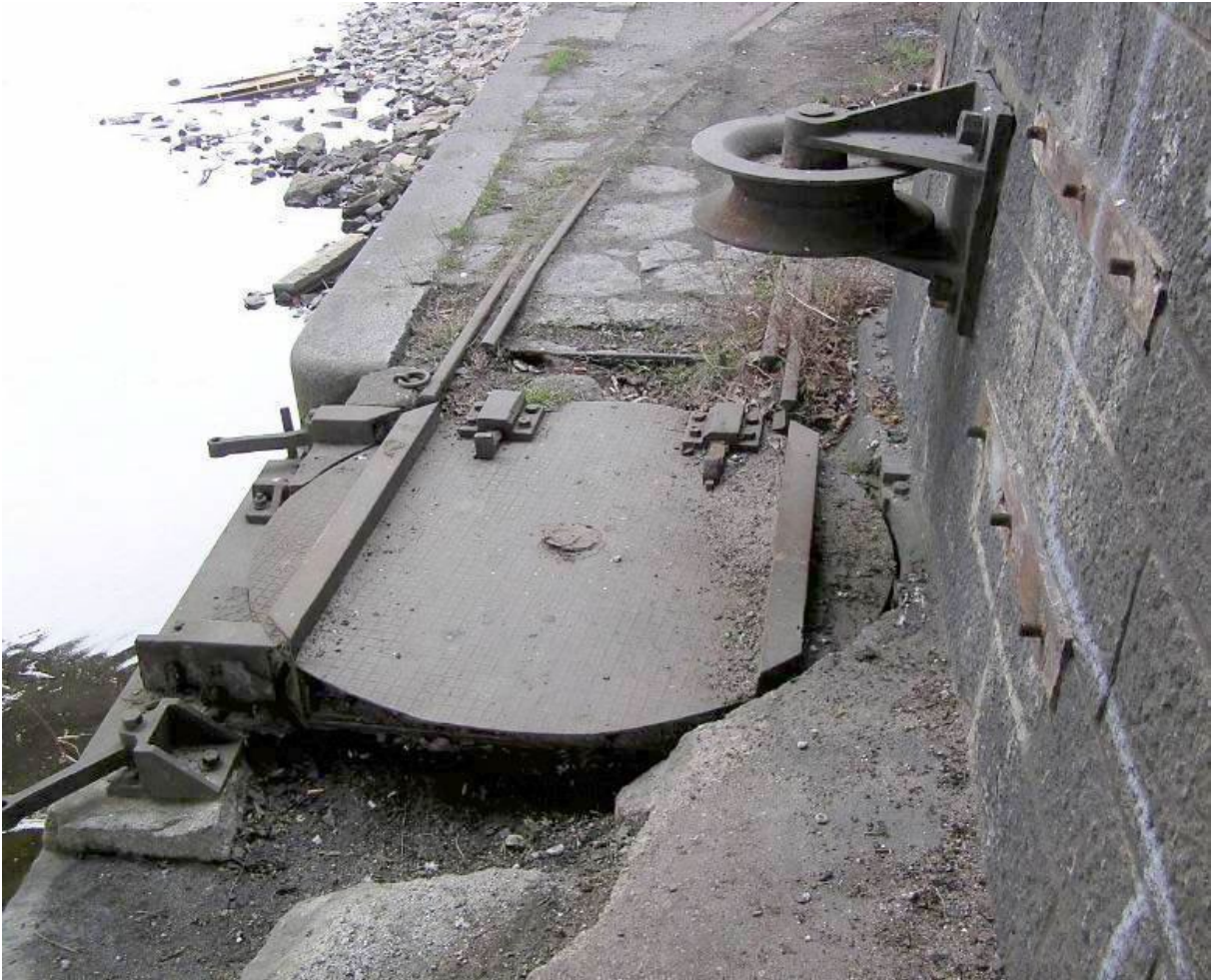
Obrotnica, tory i bloczek (bez osłony) liny do stawiania i kładzenia jazu od górnej wody. 2004 r.
