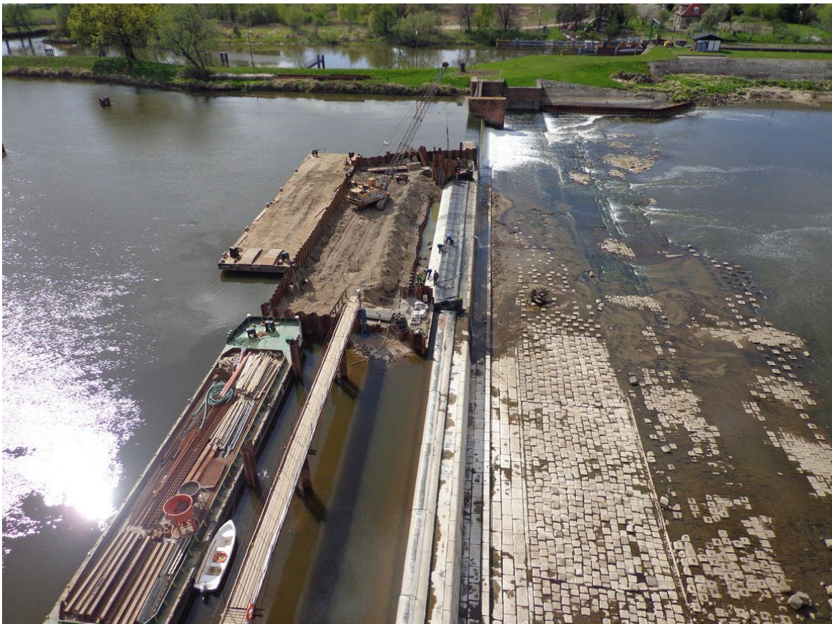
Przebudowa jazu (głównego na klapowy).
