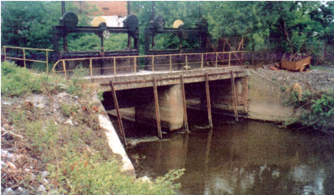
Jaz zasuwowy na kanale roboczym Młynówki.
