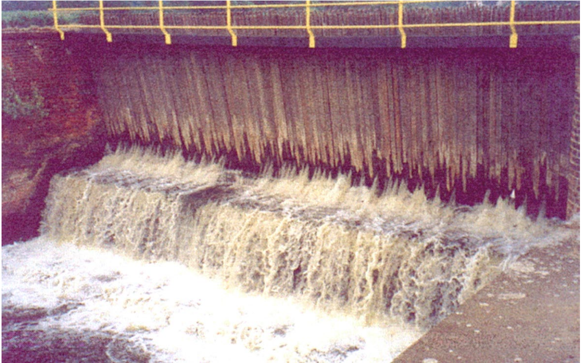
Zamknięcie iglicowe upustu płuczącego jazu stałego od dolnej wody.
