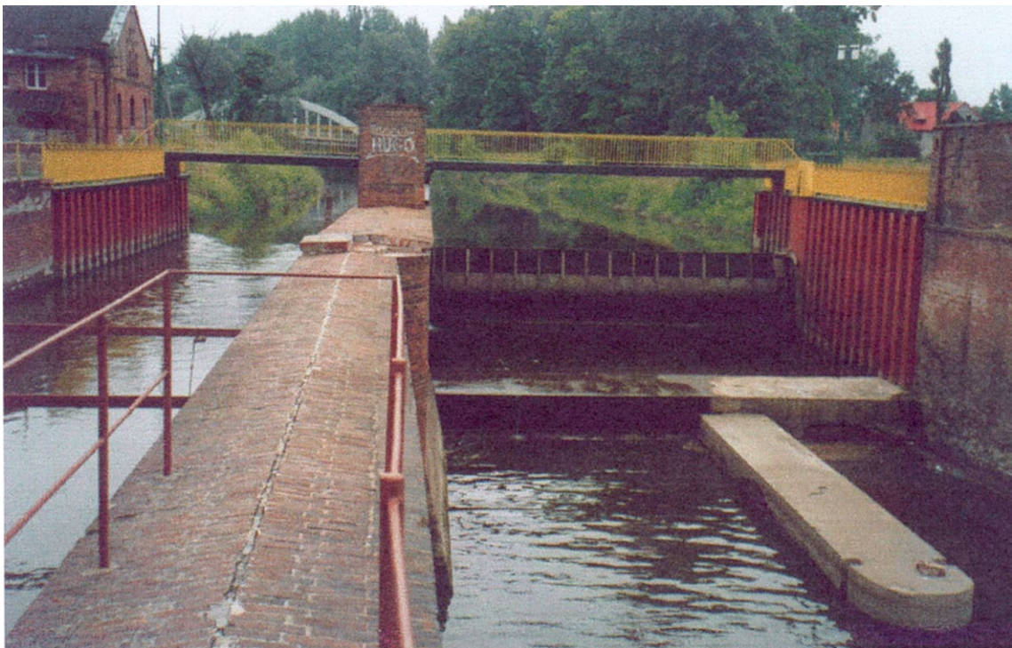
Jaz kłapowy na Młynówce od dolnej wody. Po lewej kanał wlotowy do elektrowni wodnej. Nad nimi – kładka komunikacyjna.
