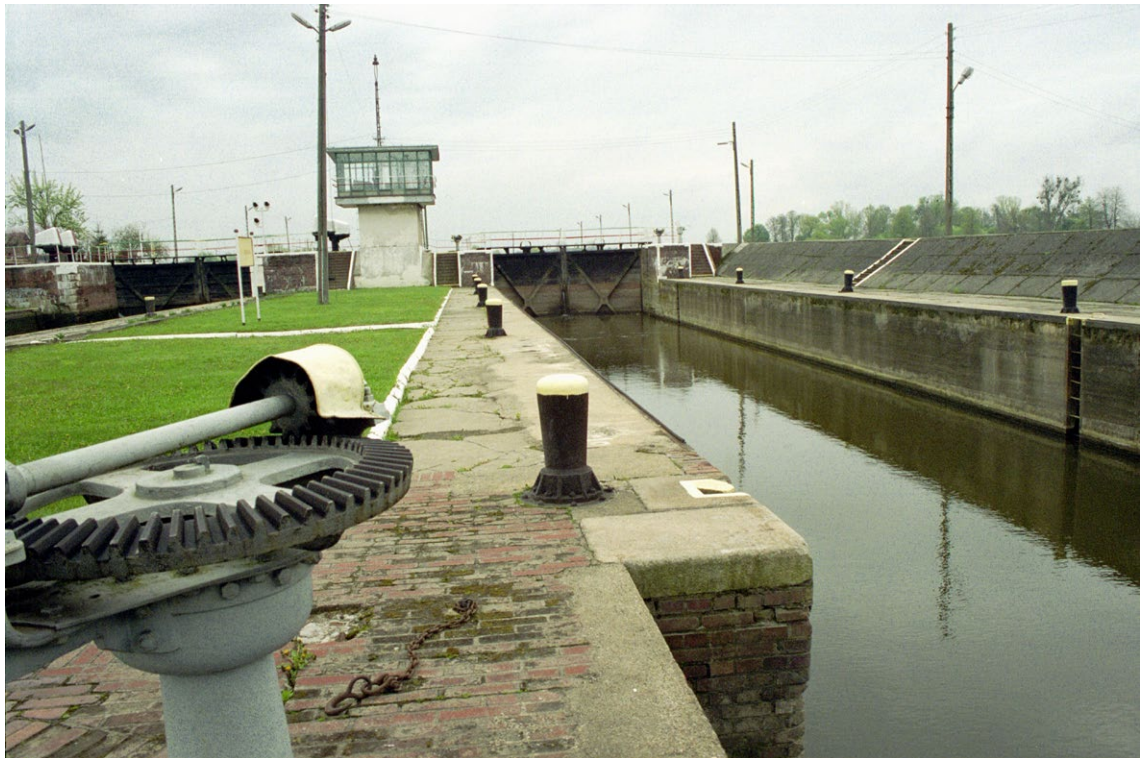
Śluza mała z jednym z ręcznych mechanizmów napędowych, wrota górne i sterówka śluz – przed modernizacją.
