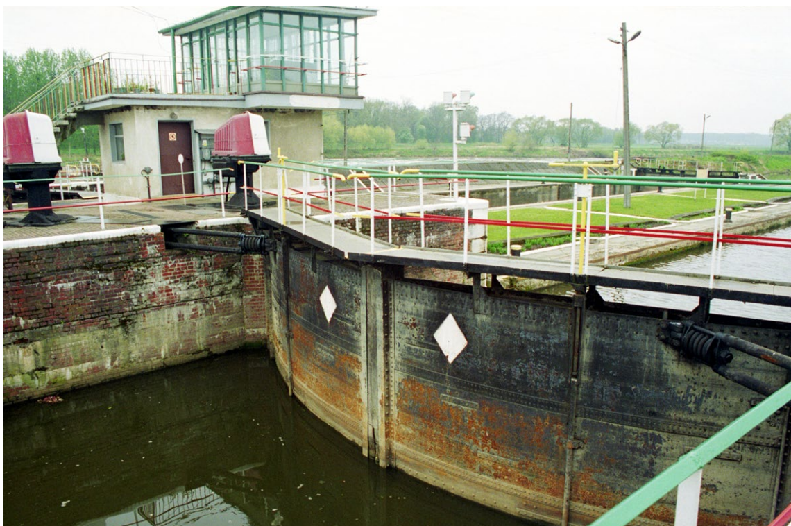
Wrota górne śluzy pociągowej, sterownia śluz i głowa dolna śluzy małej – przed modernizacją.
