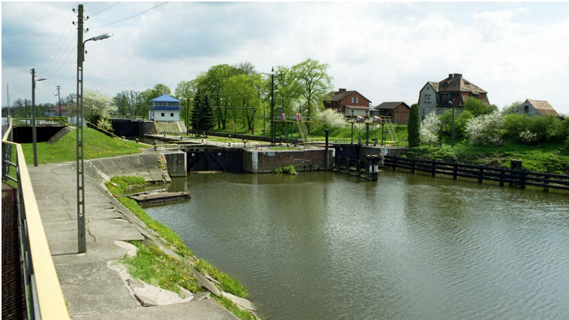
Widok na awanport dolny śluz i zabudowy przystopniowej.
