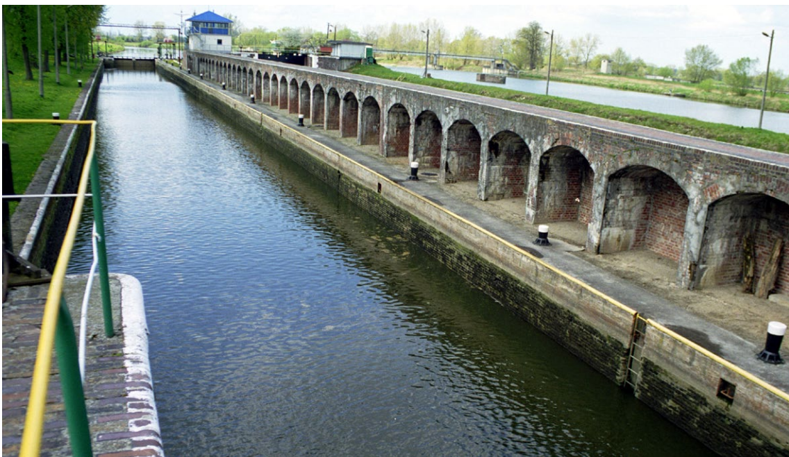
Widok od górnej wody na komorę śluzy pociągowej, filar nurtowy jazu kozłowo-iglicowego (nieczynnego), sterówkę i jaz sektorowy z kładką.
