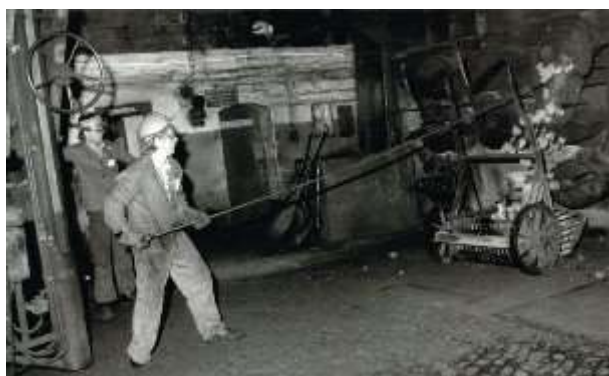
Opróżnianie retorty ze zgasowanego węgla w gazowni w wielkopolskim Śmiglu ok. 1980 r., foto Archiwum FOMT
