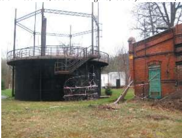
Międzylesie, Teleskopowy zbiornik gazu typu mokrego, foto S. Januszewski, 2013
