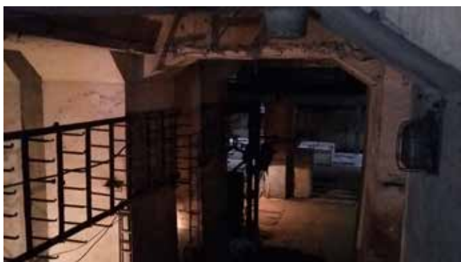
Galeria z widokiem na halę kotłową
