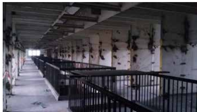
Pomieszczenie rozdzielni na poszczególne lokalizacje
