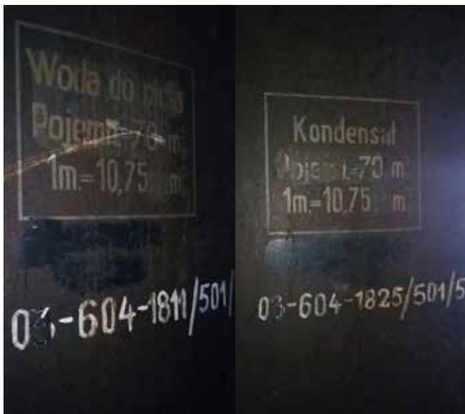
opisy na zbiornikach w wieży wodno-zegarowej
