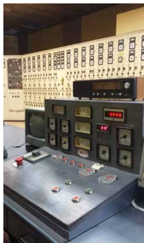
Sala z tablicą rozdzielczą
