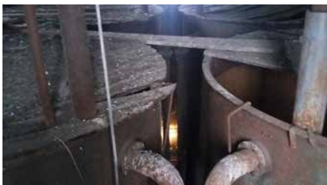
Zbiorniki w wieży wodno-zegarowej
