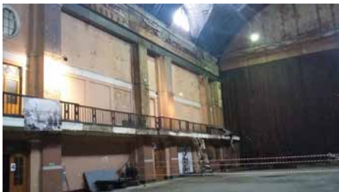
Duża hala maszyn z widokiem na rozdzielnię
