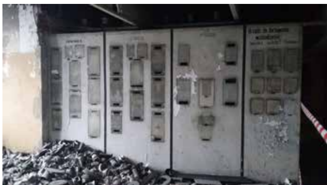
Urządzenie do wzbudzania generatorów
