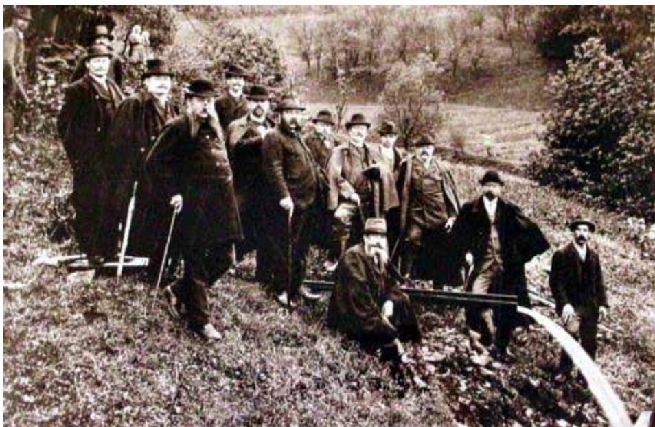
Ujęcie wody w Tyrach i grupa założycieli wodociągów – 1894
