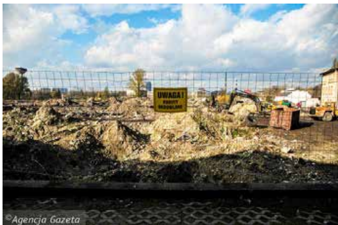
Kwiecień 2019 wyburzenia na terenie Huta im. Mariana Buczka przy ul. Staszica
