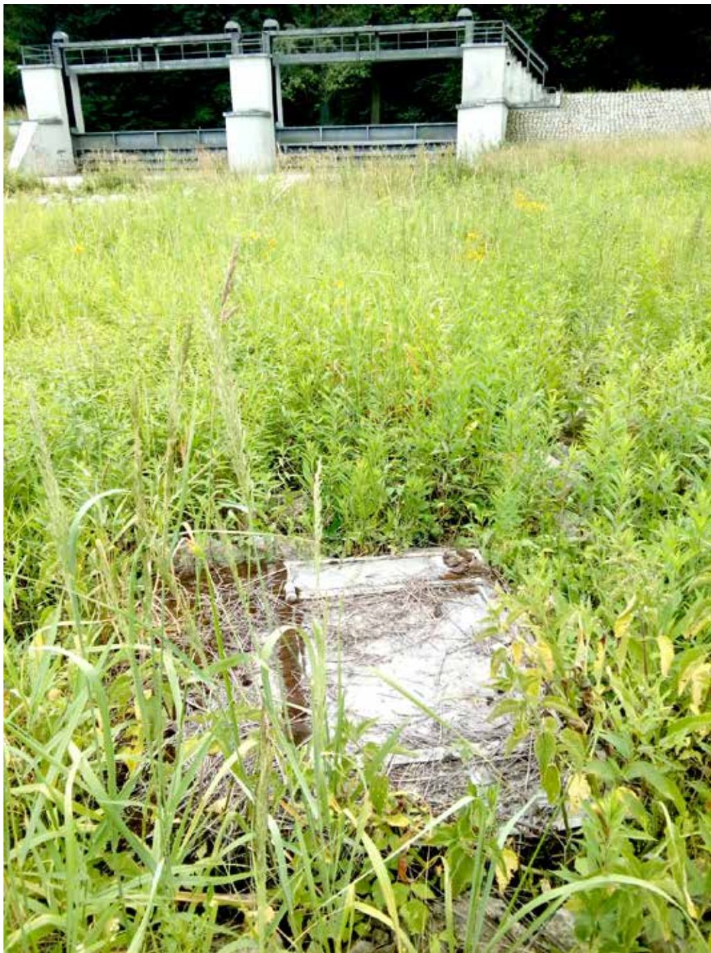
Widok budowli wlotowej od strony polderu (wody dolnej).
