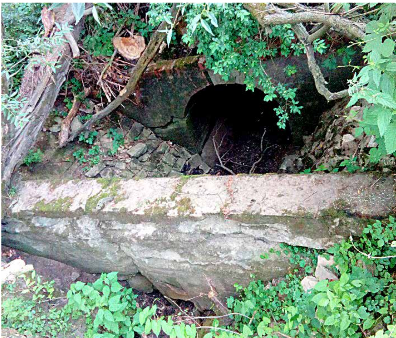
Stan przepustowości urządzeń wlotowych wód z Kanału Janowickiego do kompleksów leśnych.
