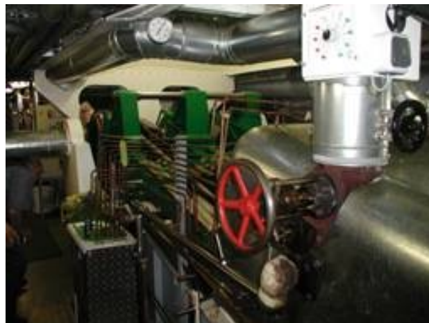
Dwucylindrowy silnik parowy produkcji CKD Praha, powstały w 1939 r., o mocy 155 KM (113 kW) przy 45 obr/min.
